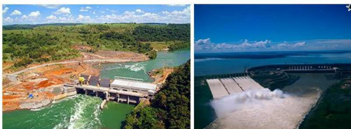
Figura 3 – Usina a fio d'água e com reservatório de acumulação.
