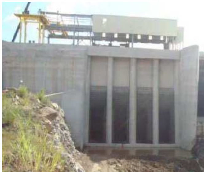
Figura 12 – Tomada D'água PCH Lavrinhas- SP
