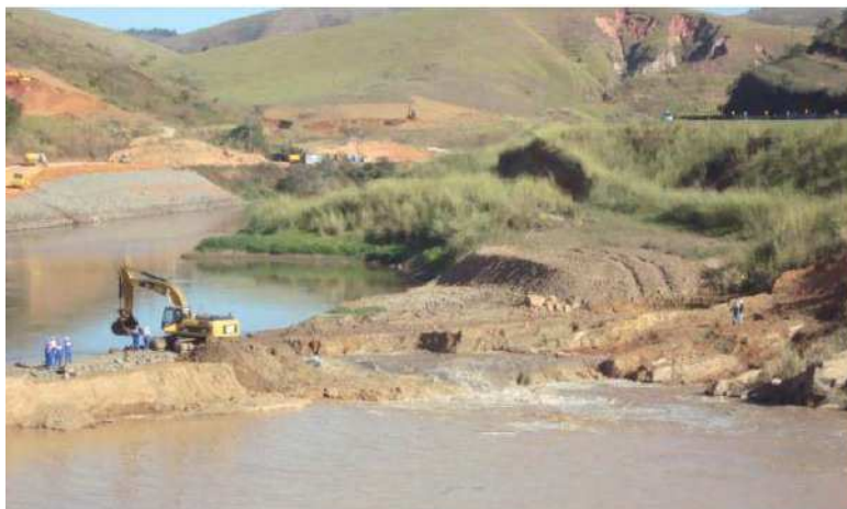
Figura 10 – Abertura da ensecadeira da PCH Lavrinhas – SP.
