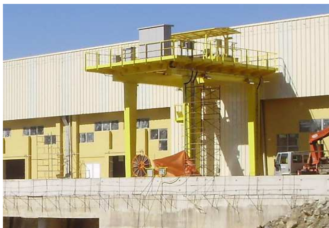
Figura 15 – Pórtico Rolante PCH Queluz-SP
