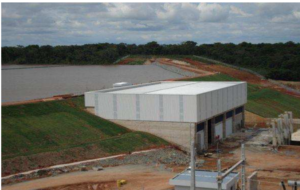
Figura 8 – Reservatório da Usina Paranatinga – MT.
