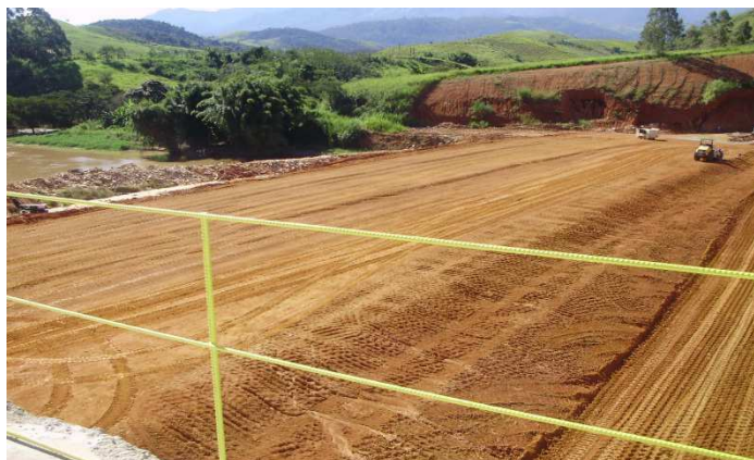
Figura 9 – Barragem da PCH Queluz-SP.
