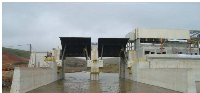
Figura 11 – Vertedouro da PCH Lavrinhas - SP.
