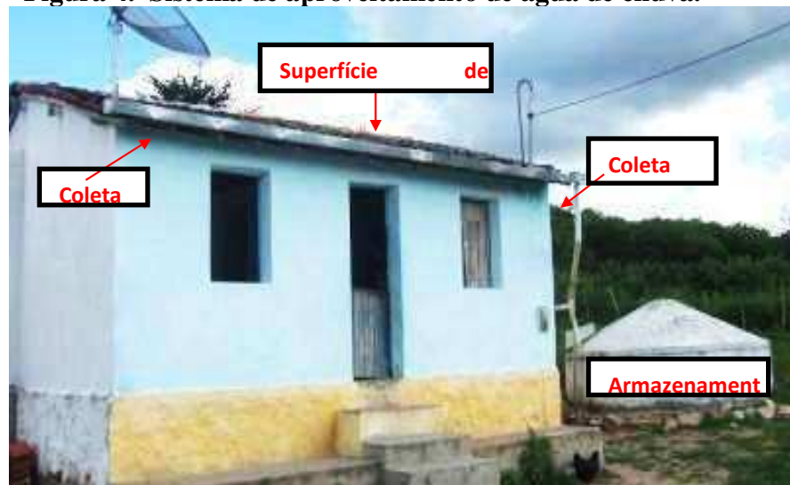
Figura 4. Sistema de aproveitamento de água de chuva.
