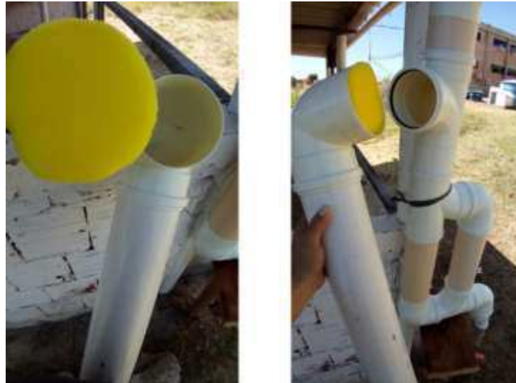
Figura 24. Esponja sendo instalada na saída de água do Desvio.
