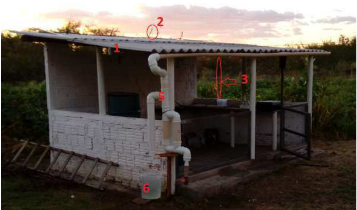
Figura 19. Equipamento de simulação de chuva e desvio das primeiras águas de chuva.
