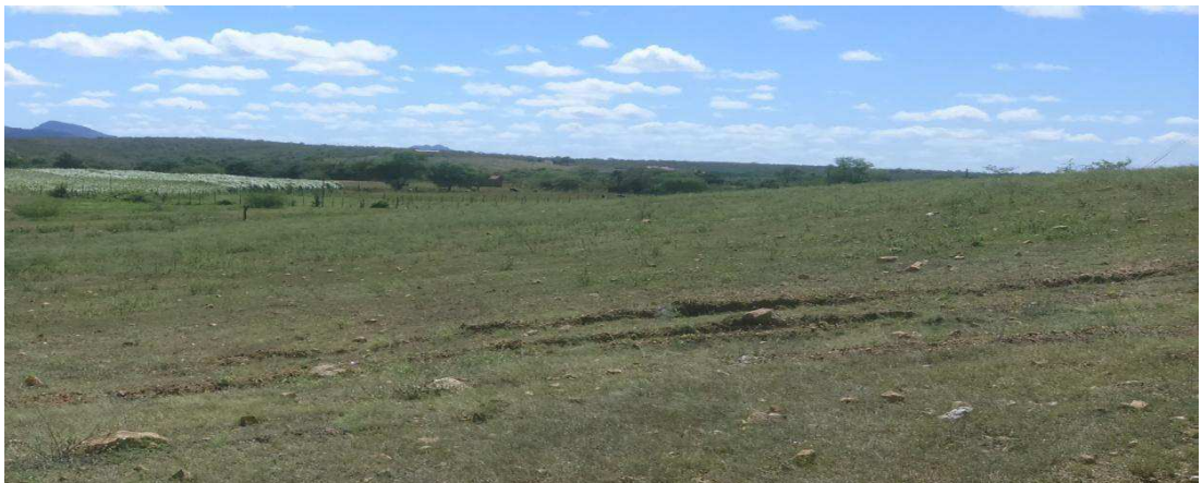
Figura 17 - Erosão em sulcos.
