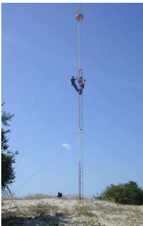
Figura 42. Torre de monitoramento anemométrico de 50 metros de altura (COSERN).
