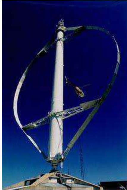
Figura 5. Turbina eólica de eixo vertical do tipo Darrieus. (Fonte: http://engambiente3.blogspot.com.br/ )
