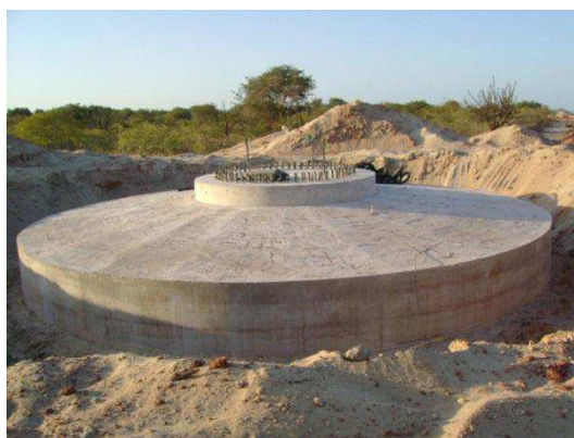
Figura 33. Base do aerogerador.
