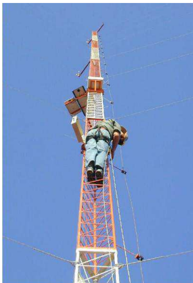
Figura 41. Detalhe da torre anemométrica (COSERN).
