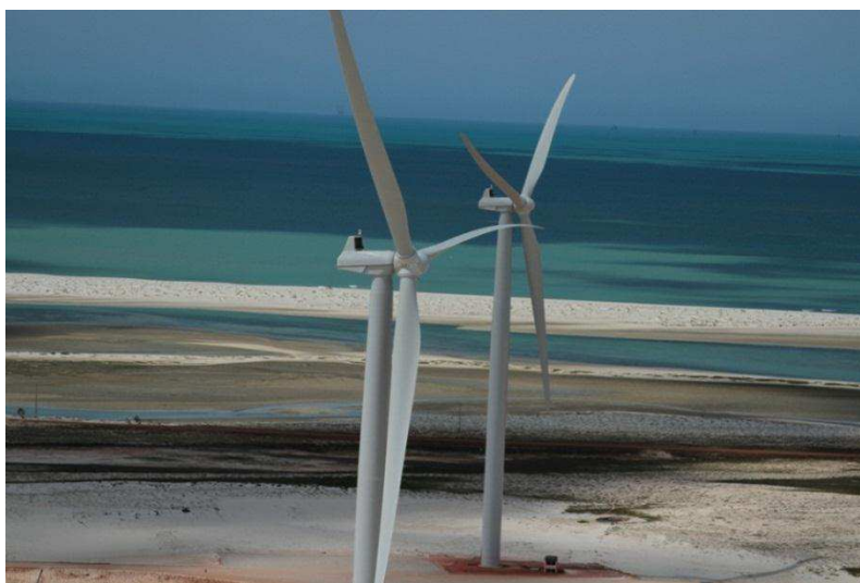
Figura 25. Vista do parque eólico Alegria I.
