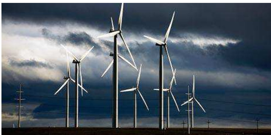
Figura 35. Aerogerador Vestas V82-165
