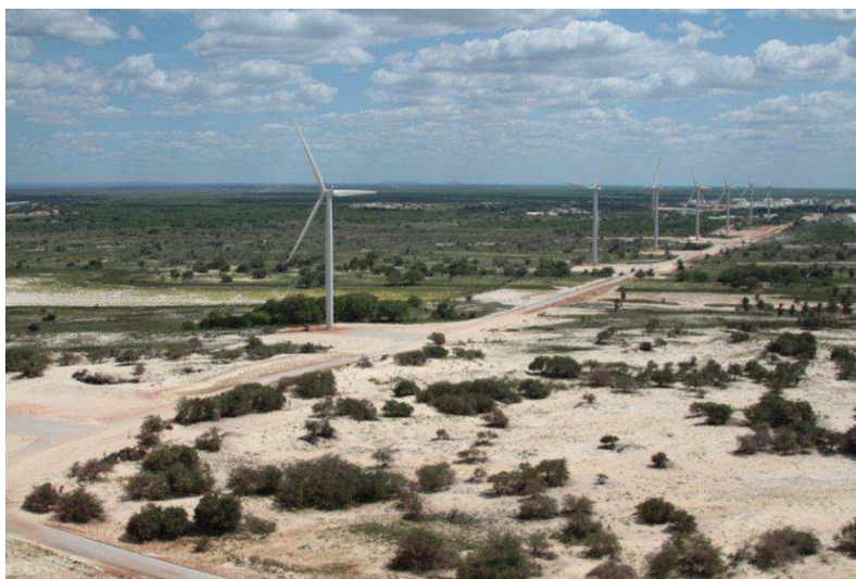
Figura 26. Vista do parque eólico Alegria I.
