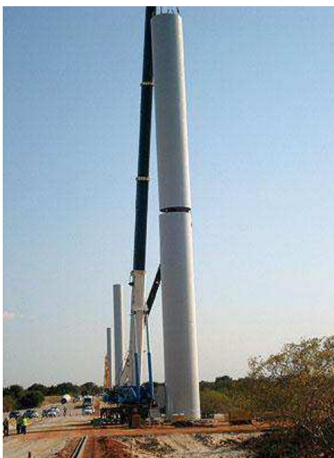
Figura 34. Içamento e encaixe do segundo tramo.
