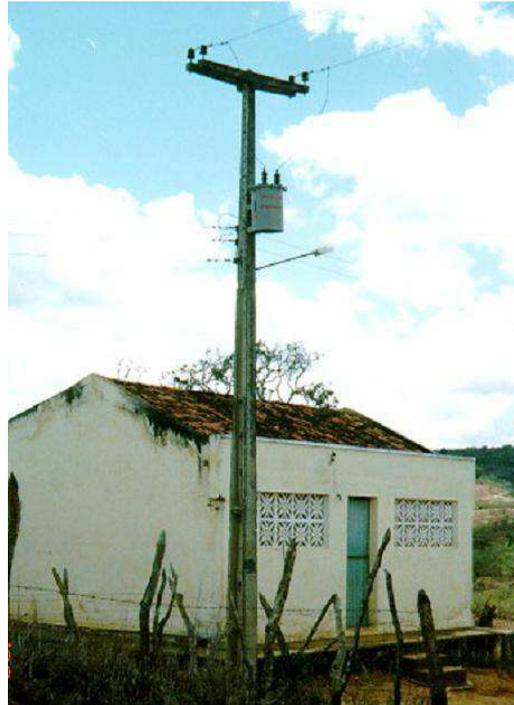
Figura 38 – Transformador monofásico de distribuição (núcleo de liga amorfa) de 15 kVA 13800 V / 220 V instalado na zona rural de Massaranduba.
