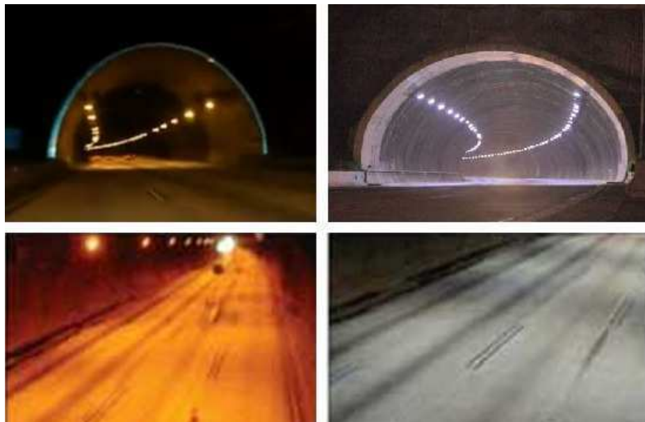
Figura 58. Antes e depois da iluminação a LED do Túnel 2 do rodoanel Mario Covas. Fonte: Lumilândia – Rodoanel em São Paulo com lâmpadas de LED, 2011.
