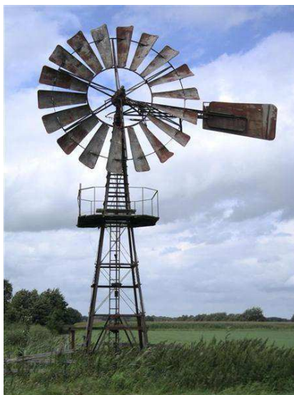
Figura 21. Turbina eólica de eixo horizontal com multipás ( http://pt.wikipedia.org , 2013).
