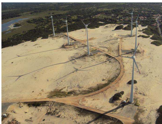
Figura 26 - Usina eólica de Beberibe Fonte - http://www.mercurius.com.br
