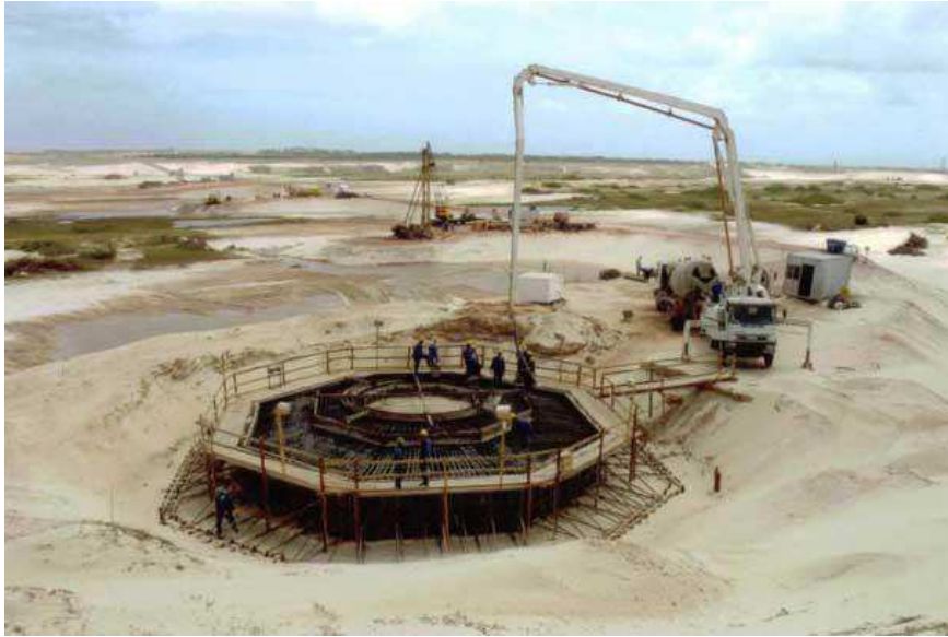
Figura 16 - Concretagem da fundação de um Aerogerador Fonte - http://www.piniweb.com.br
