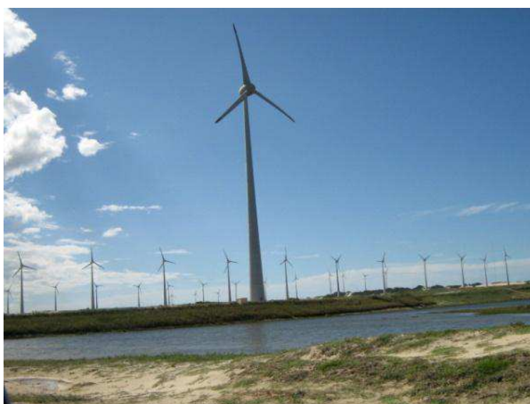
Figura 32 - Usina eólica Rio do Fogo Fonte - http://www.mercurius.com.br
