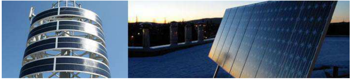
Figura 3.9– Torres de telecomunicação com alimentação através de energia solar.
