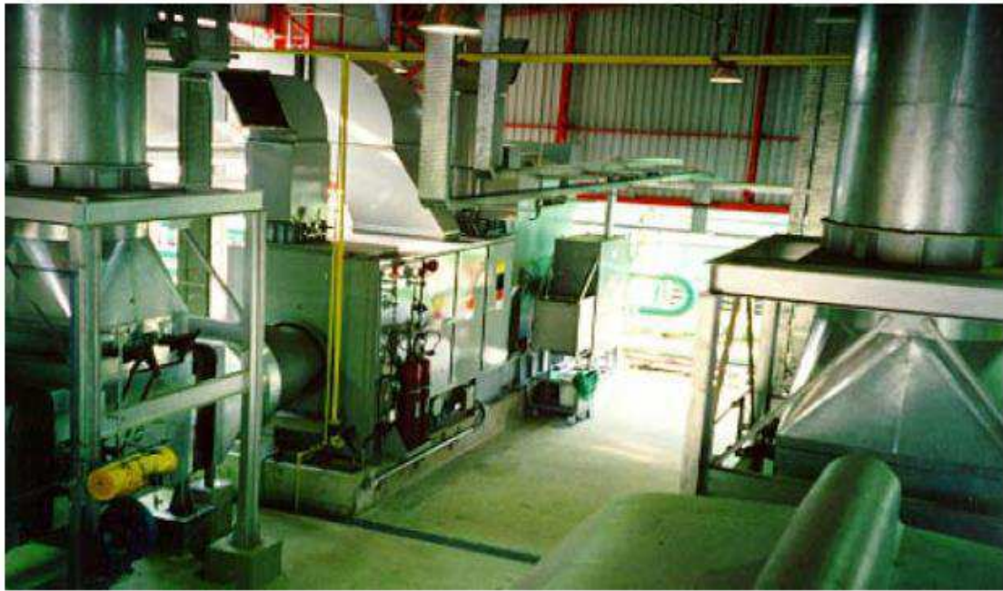
Figura 18 Sistema de turbinas a gás (Fábrica da Cerveja Kaiser - Brasil) (apud (Brandão, 2004)).
