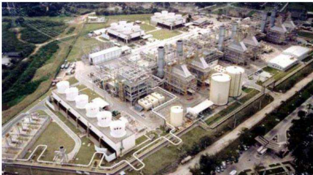
Figura 21 Central Cogeneradora TermoRio, 1.040 MW, Duque de Caxias-RJ. (Foto: TermoRio S.A., 2004)
