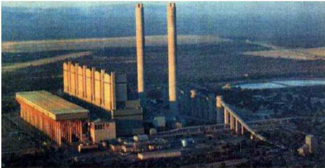
Figura 15 Instalação industrial onde se usa turbinas a vapor. Notar à esquerda caldeira de condensação, uma das maiores do mundo (Matimba, África do Sul).
