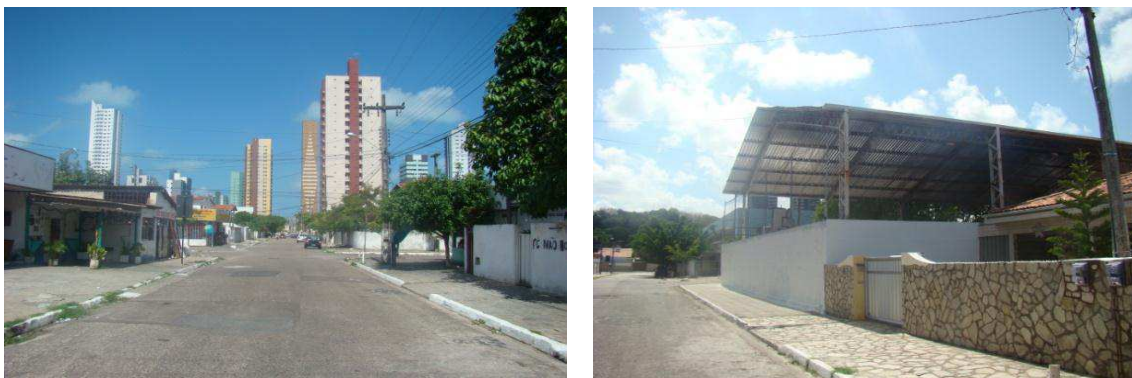
Figura 12. Vistas da área do entorno do ponto P03 (Bairro Manaíra) dentro da malha urbana da cidade de João Pessoa, PB
