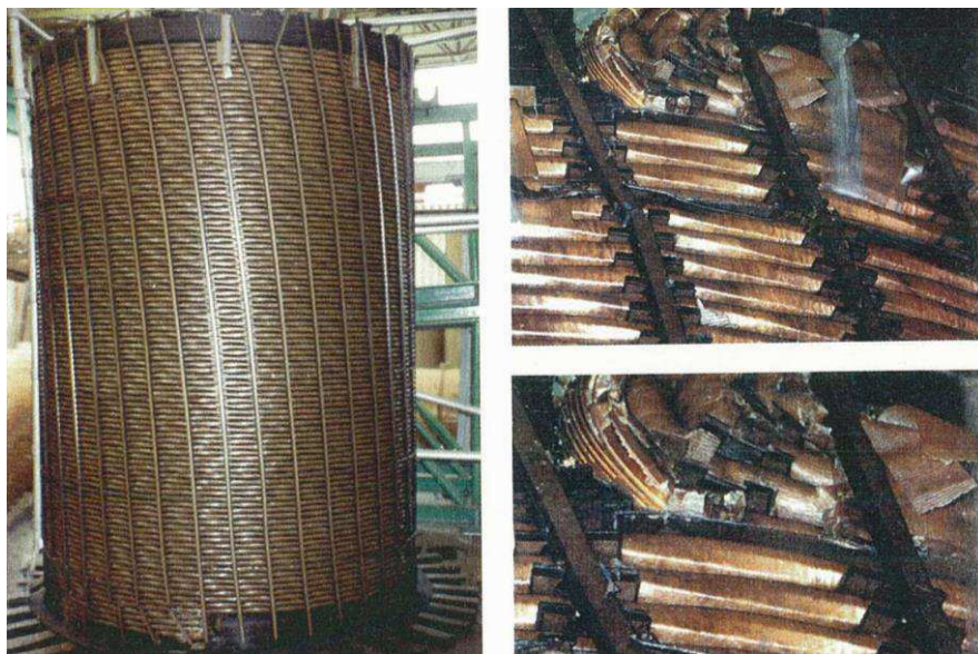
Figura 11 – Espiralling ocorrido na camada externa de um enrolamento helicoidal de dupla camada de um transformador de 350 MVA submetido a um teste de curto circuito.
