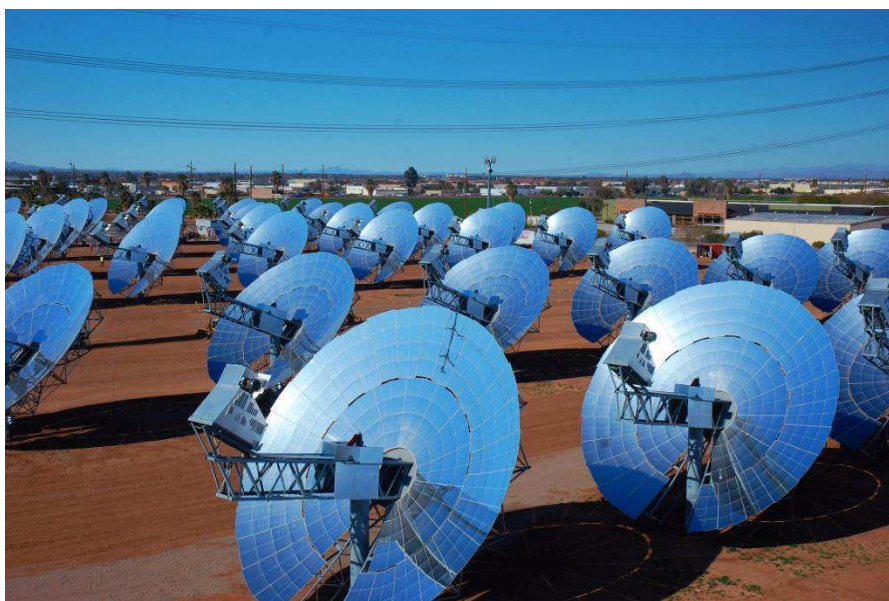
Figura 21: Usina solar que utiliza a tecnologia de pratos parabólicos, no Arizona, USA
