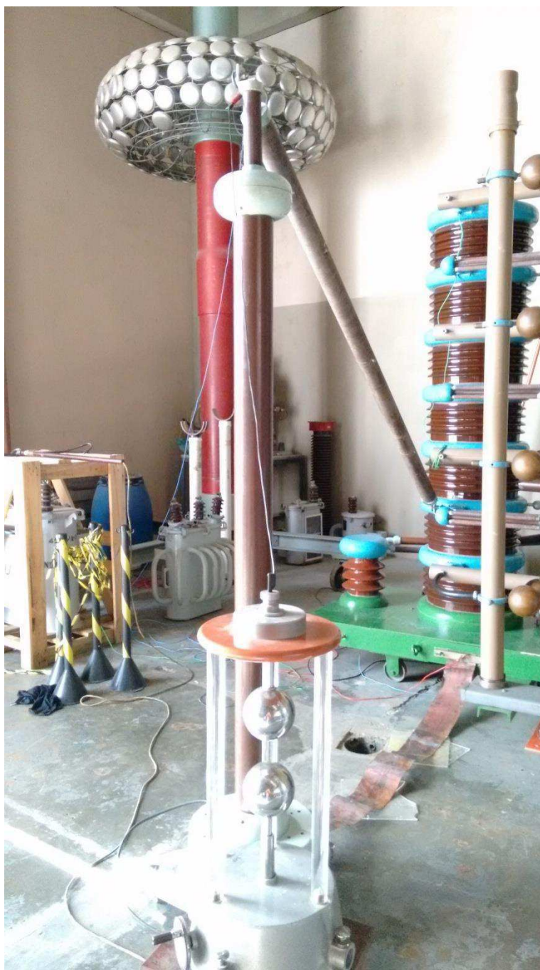
Figura 18 – Saída do gerador de impulso de tensão.
