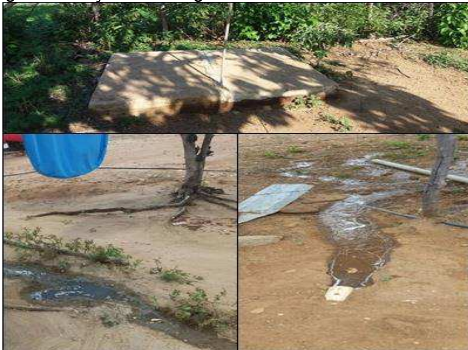
Figura 5 - Lançamento de águas cinza no solo e fossa rudimentar.
