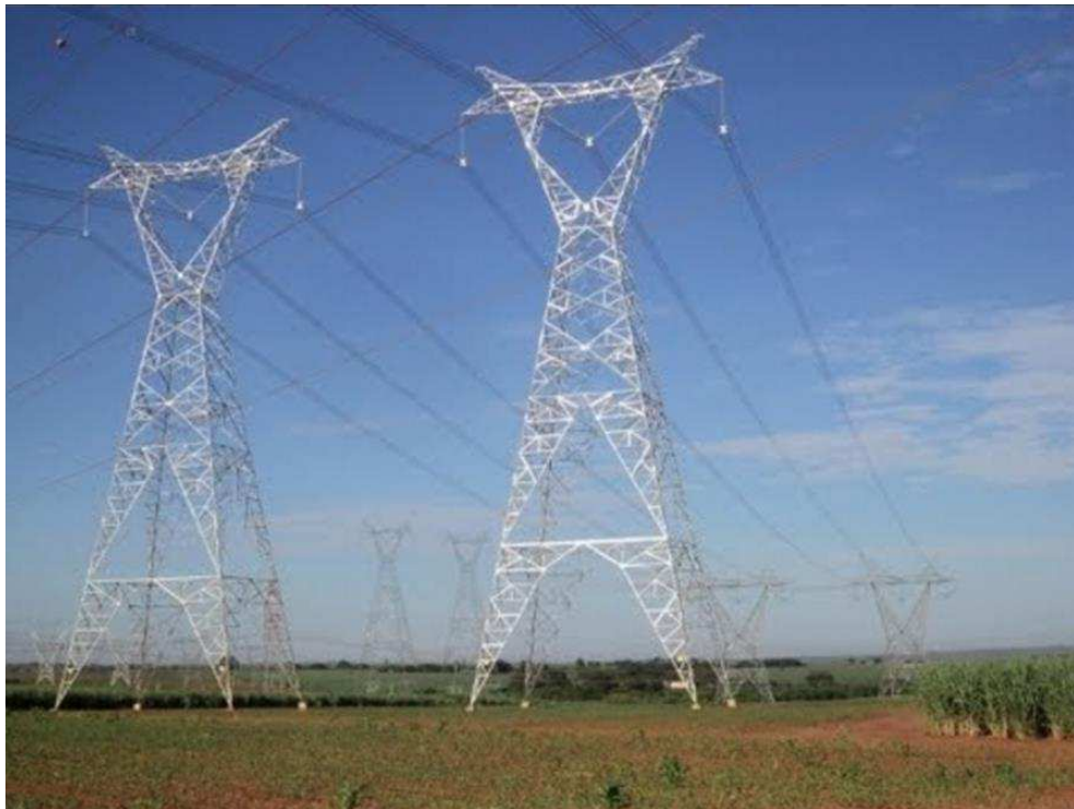
Figura 2.2- Linhas de transmissão de circuito duplo. Fonte: Desconhecida.
