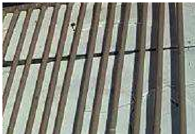
Figura 17 - Folhas de isopor sob o coletor solar.
