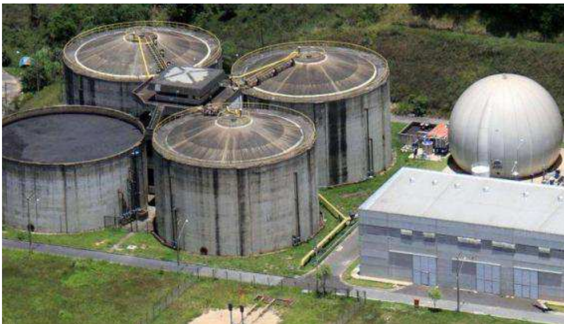
Figura 17: ETE Arrudas, Unidade de Cogeração
