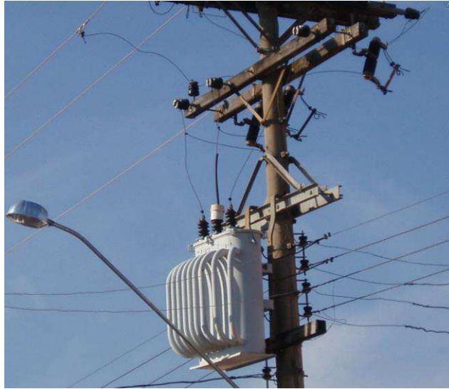
Figura 4 - Estação Transformadora.
