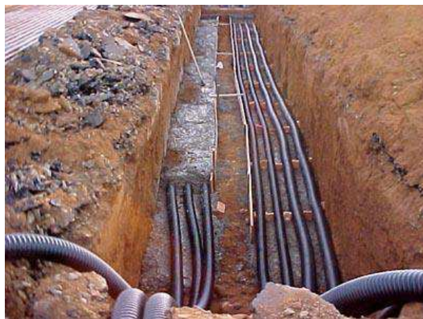
Figura 3 - Rede de Distribuição Subterrânea.
