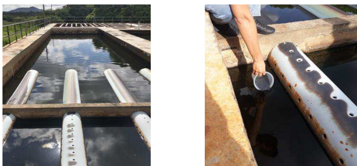
Figura 22: Coleta amostra d'água indo para os filtros após decantação
