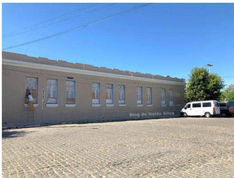
Figura 18 – Fachada lateral após pintura.
