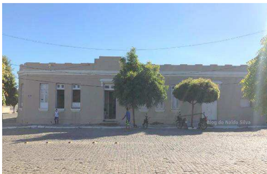
Figura 19 – Fachada frontal após pintura.
