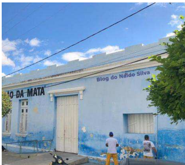
Figura 16 – Esquadrias metálicas na fachada principal.
