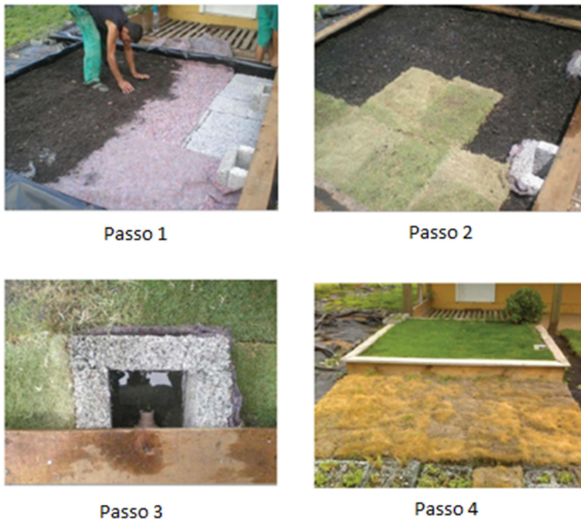
Figura 4: Passos para instalação de um sistema laminar.
