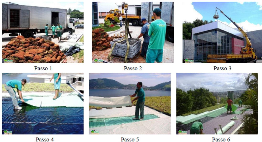
Figura 3: Passos para instalação de um sistema alveolar.
