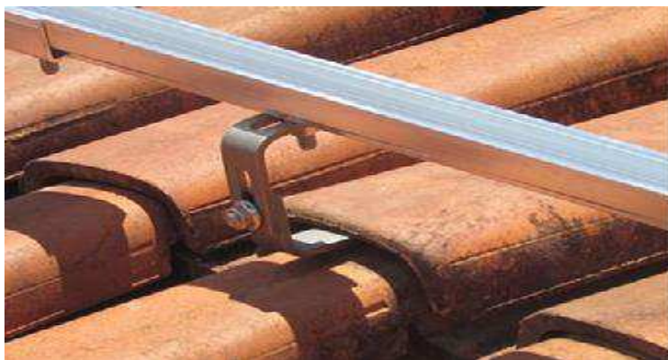
Figura 12: Estrutura de fixação de sistemas fotovoltaicos em telhas cerâmicas.
