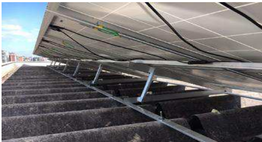
Figura 14: Fixação de estruturas em triângulo em telhas de fibrocimento.
