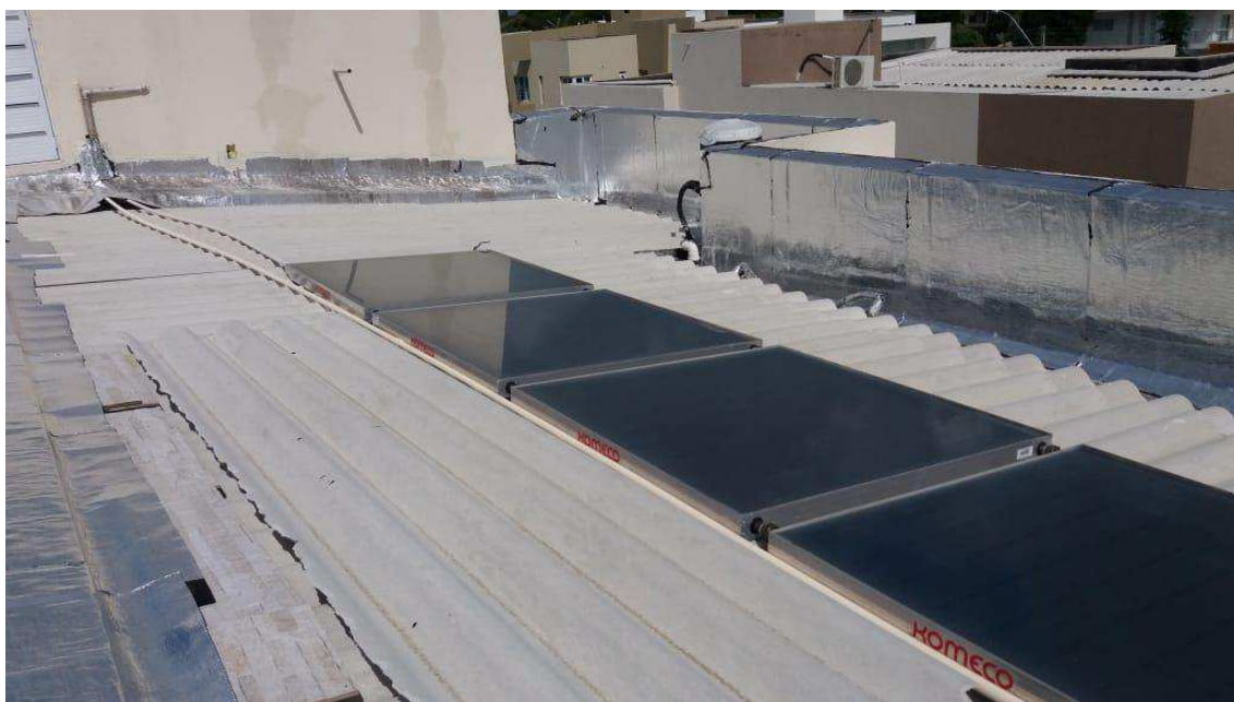
Figura 33: Telhado da residência com sistema de aquecimento de água por energia solar.
