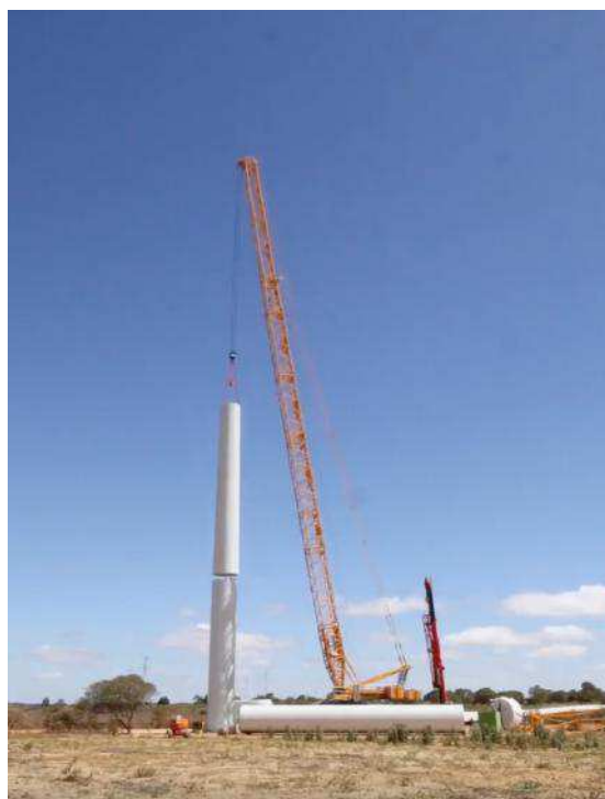
Figura 34 – Montagem da torre do aerogerador G114
