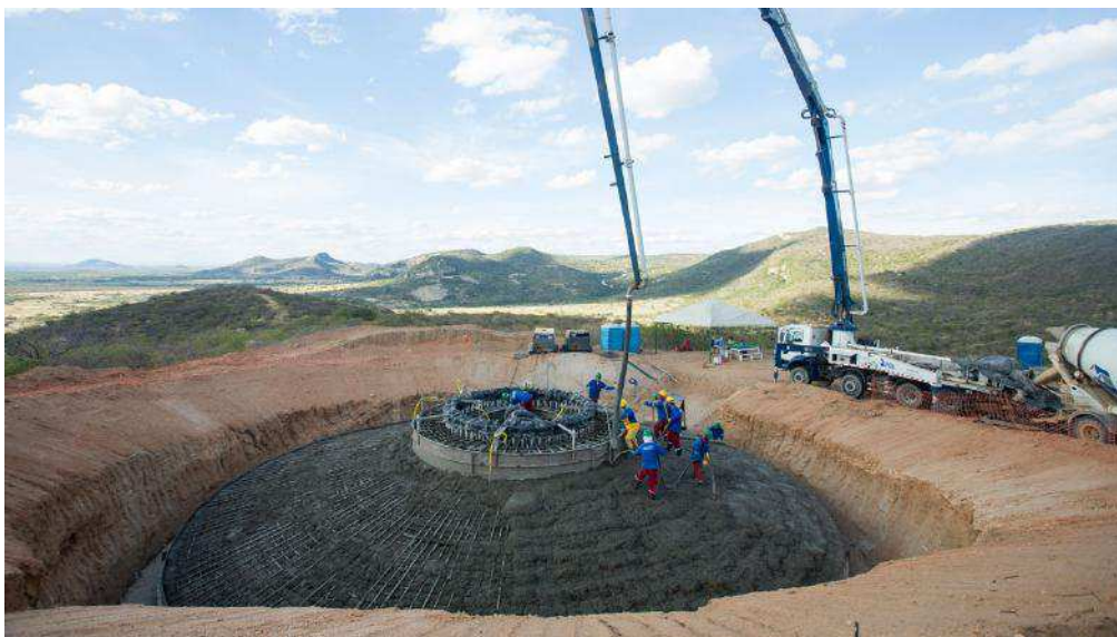
Figura 33 – Preparação da base do aerogerador G114
