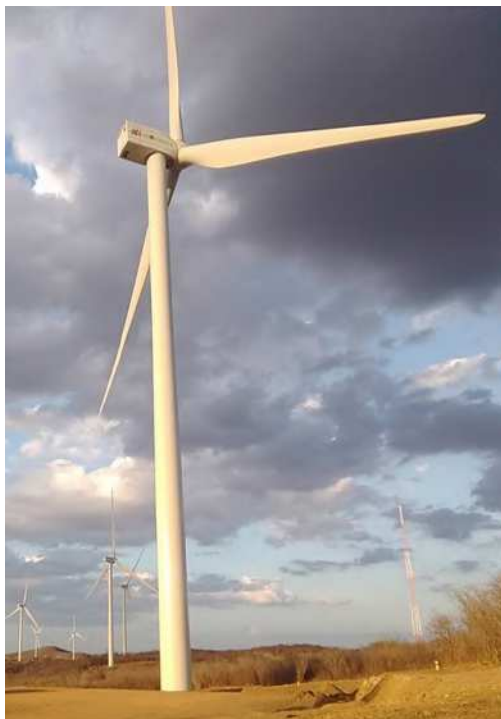
Figura 39 – Montagem completa do aerogerador G114
