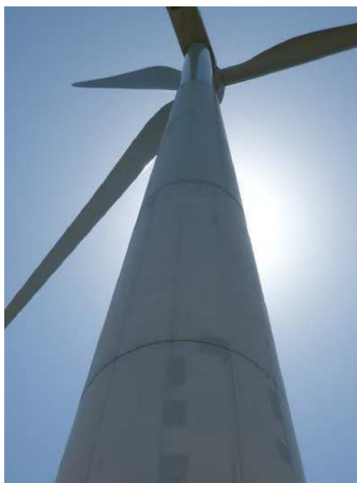
Figura 21 – Torre de um aerogerador
