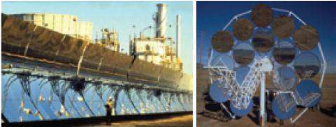
Figura 2 – Dois modelos centrais que utilizam tecnologia de concentradores solares para gerar energia elétrica.
