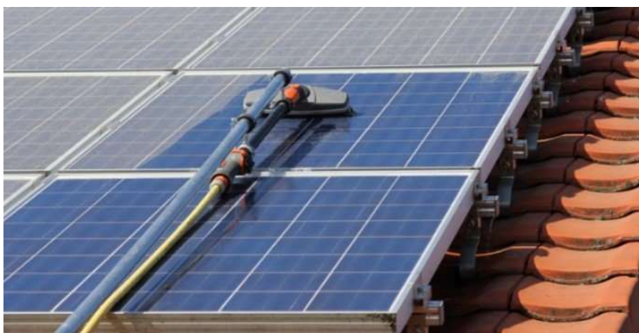
Figura 20: Foto durante limpeza necessária nos módulos
