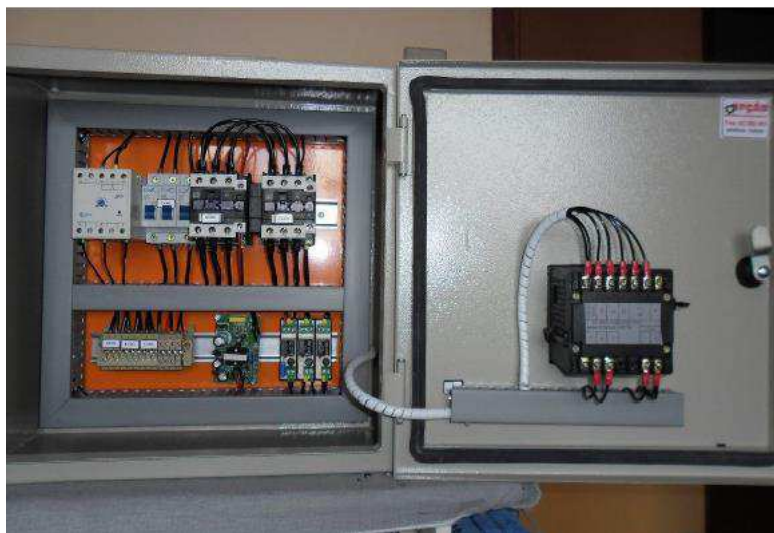
Figura 43. Exemplo de QTA com acionamento por contadores.
