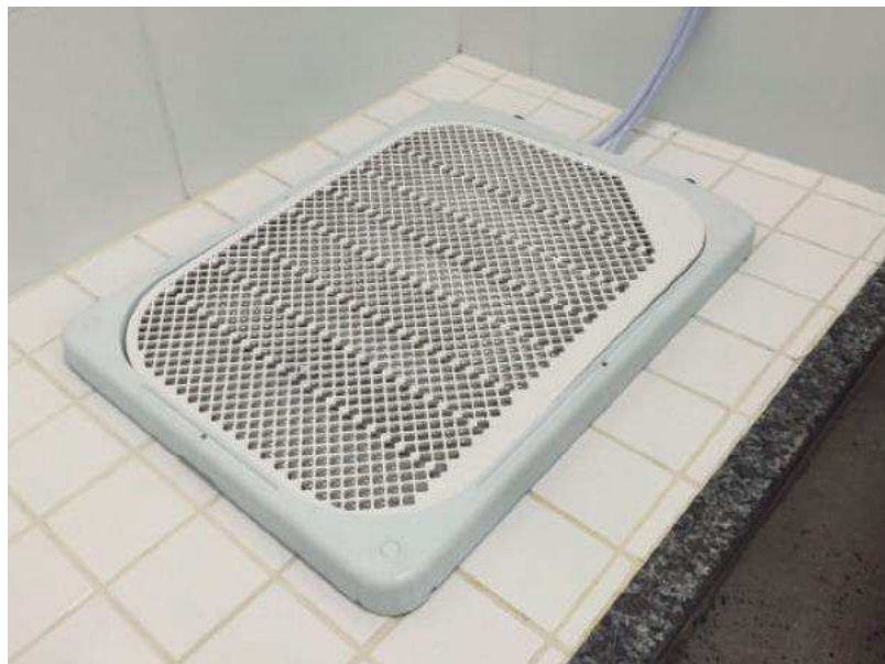
Figura 36. Plataforma de aço inoxidável do Trocado de Calor
