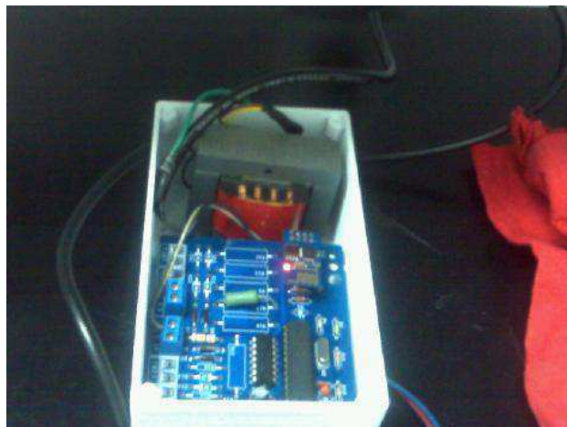
Figura 24: Imagem a luz visível realizada pelo termovisor
