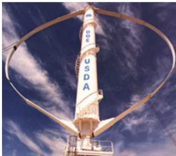
Figura 2.4 – Rotor de Darrieus.
