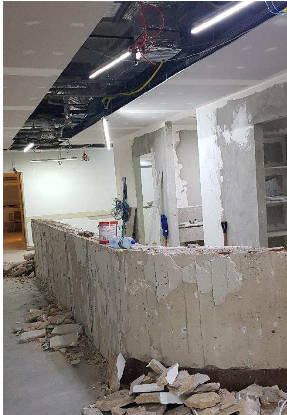
Figura 12 – Foto do posto de enfermagem durante a reforma.
