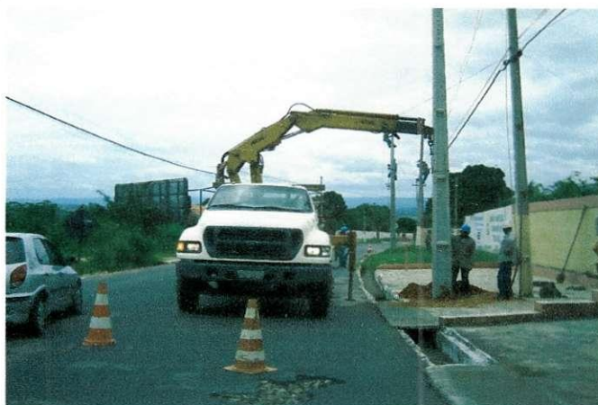
Figura 40: Implantação de poste utilizando caminhão muck.
