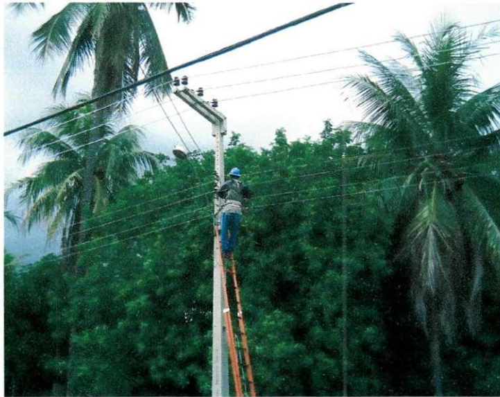
Figura 35: Substituição de ramal de ligação monofásico.
