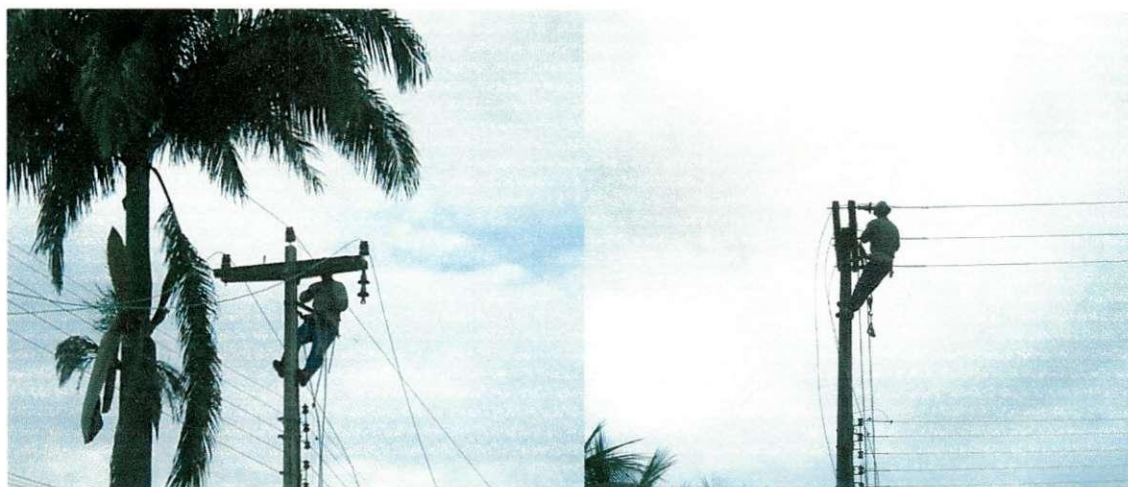
Figura 41: Lançamento de condutores convencionais e fixação do moitão para tracionamento dos cabos.
