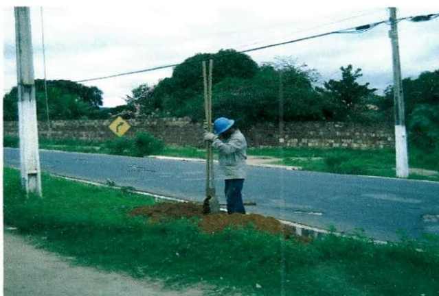
Figura 39: Abertura de cava em terreno normal para substituição de poste.
