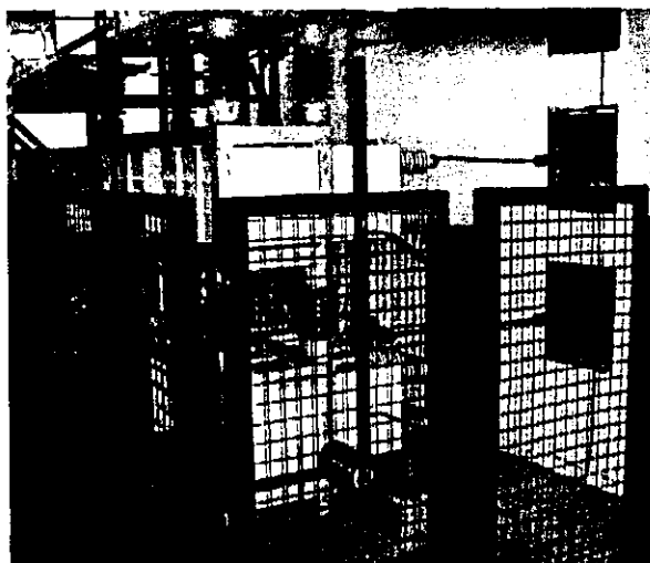
Figura 3.3.2.5: Banco de capacitores C – 20MVA
