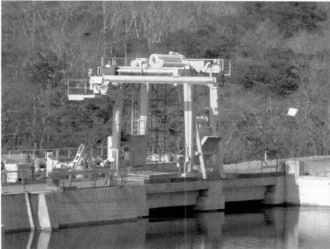
Figura 18: Pórtico Rolante PCH Porto das Pedras
