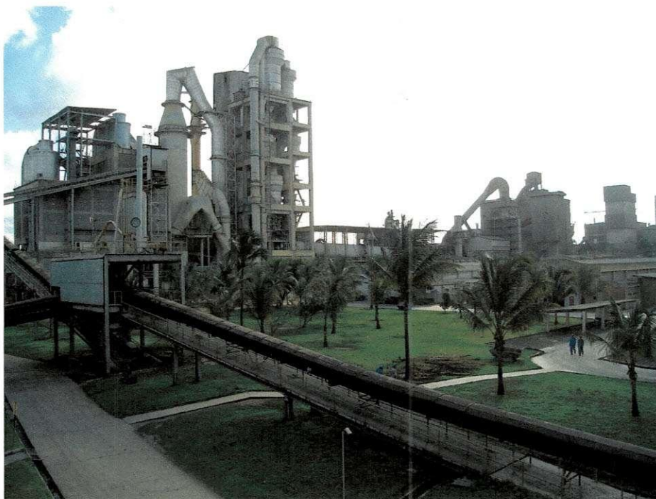
Figura A.3: CIPASA – Na seqüência do processo: correias transportadoras, balança dosadora, moagem de cru, silo de homogeneização, torre de ciclones, forno rotativo, resfriador, silo de clínquer e moagem de cimento.
