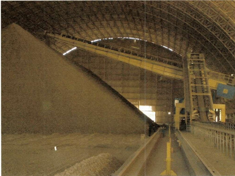
Figura A.2: CIPASA – No galpão de calcário, a empilhadeira constrói uma pilha.
