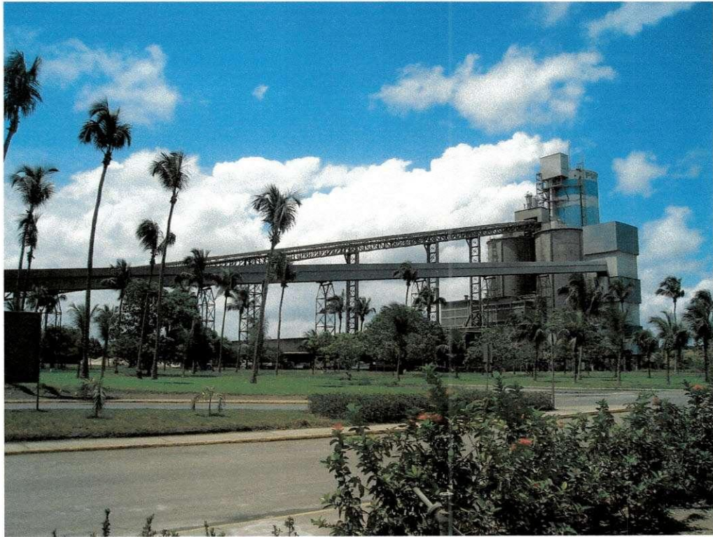
Figura A.9: CIPASA – Transporte de cimento e argamassa para os silos da ensacadeira.
