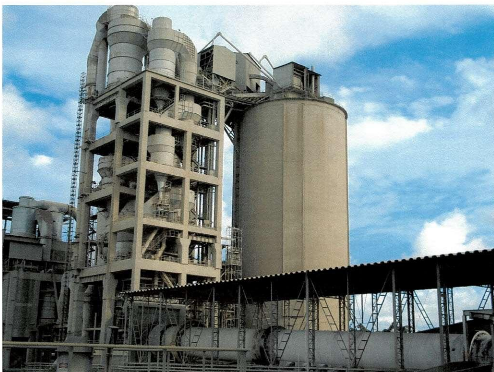
Figura A.6: Torre de ciclones, silo de farinha e forno rotativo.
