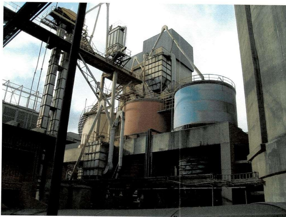
Figura A.8: CIPASA – Adição de gesso, pozolana e calcário.
