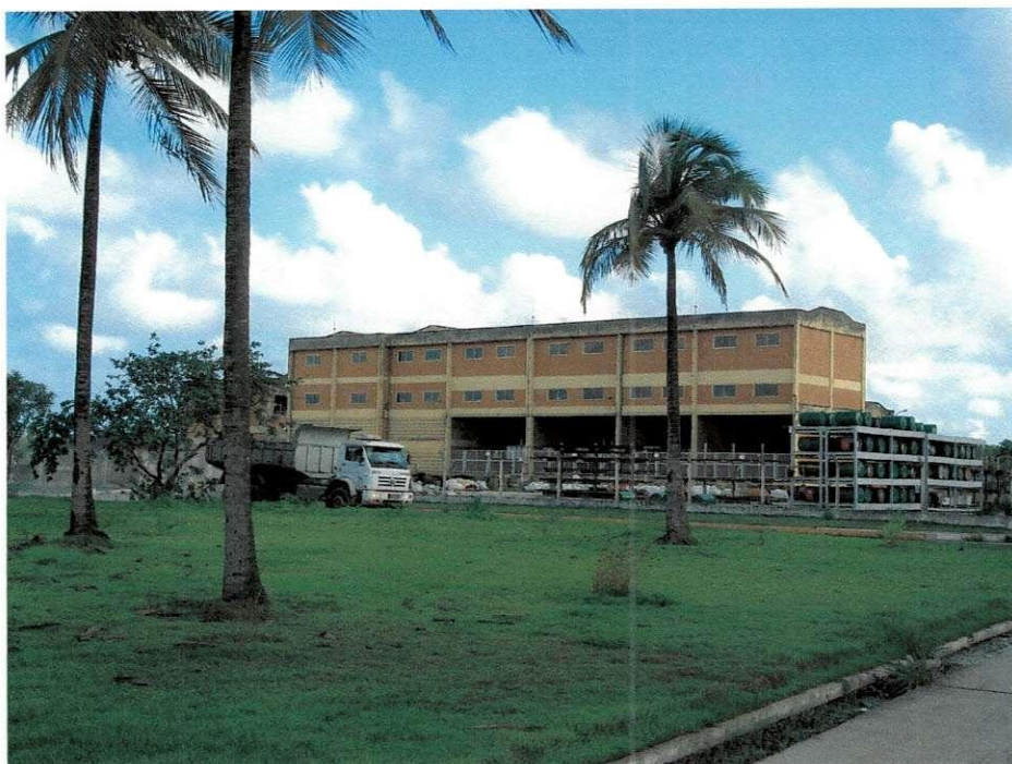
Figura A.4: CIPASA – Subestação 69 kV.
