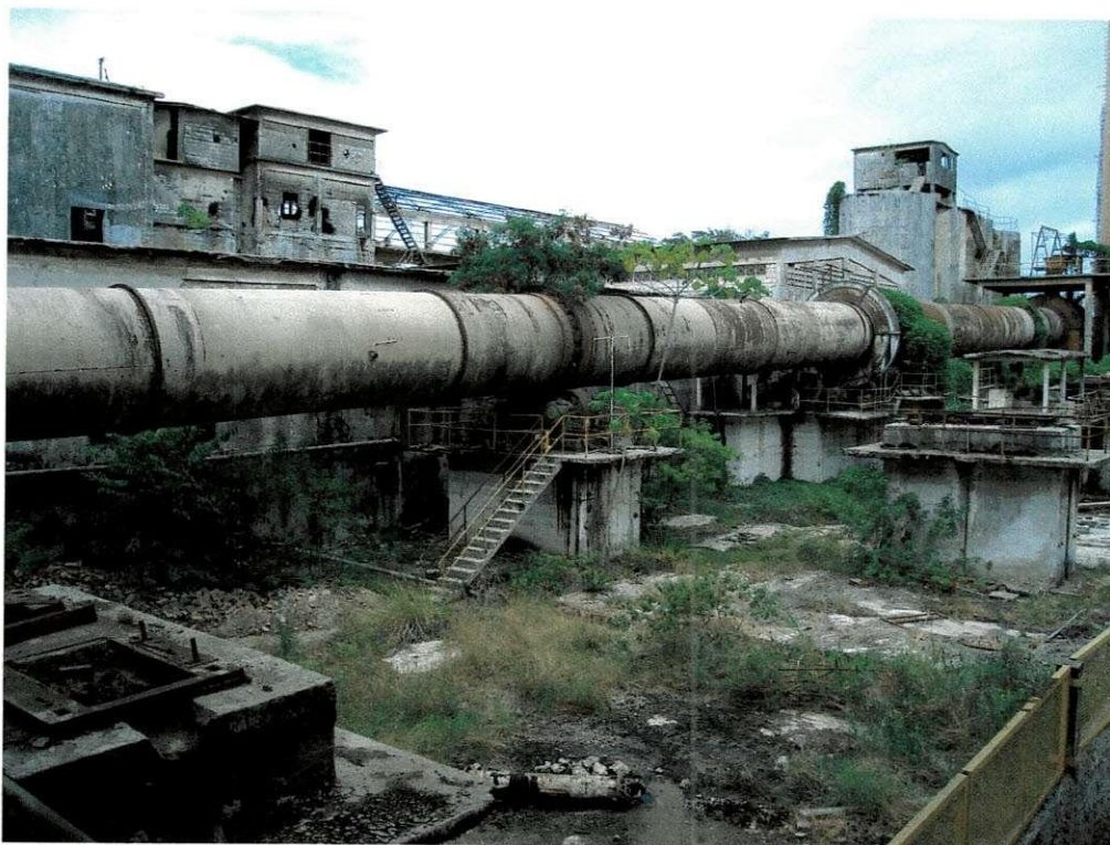
Figura 23: Companhia de Cimento Poty Paulista - Equipamentos abandonados.
