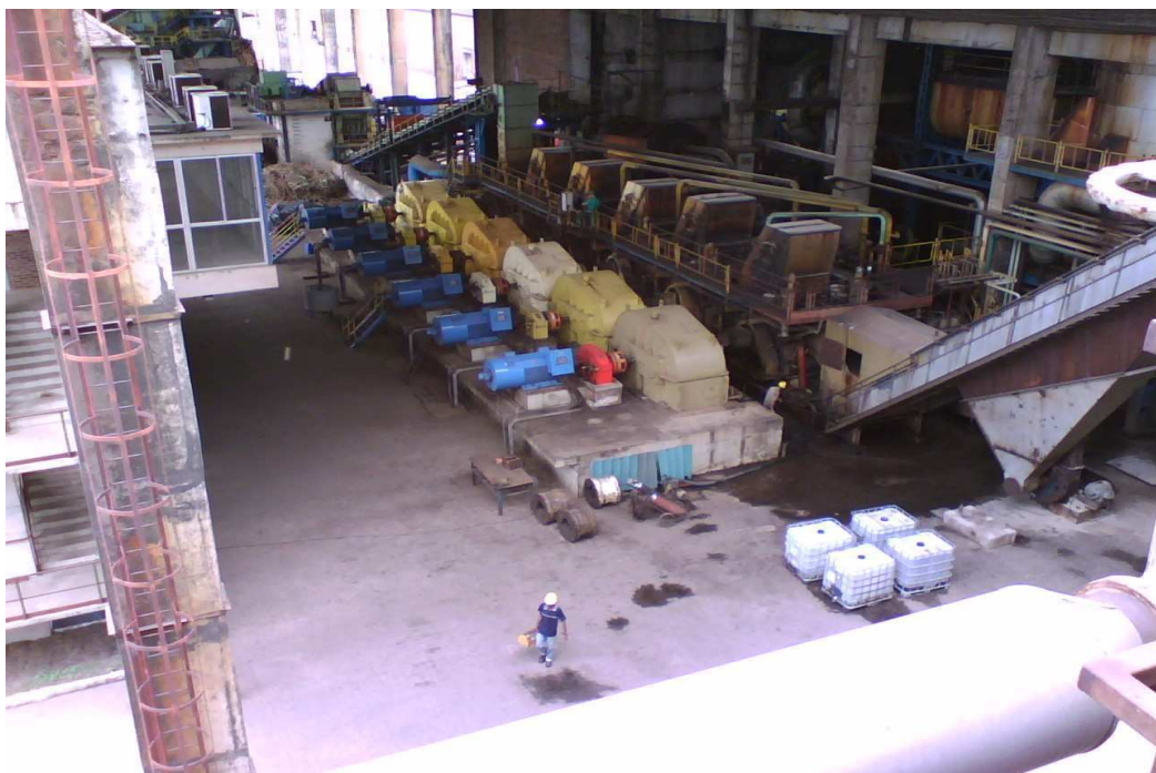
Figura 02: Preparo e moagem.
