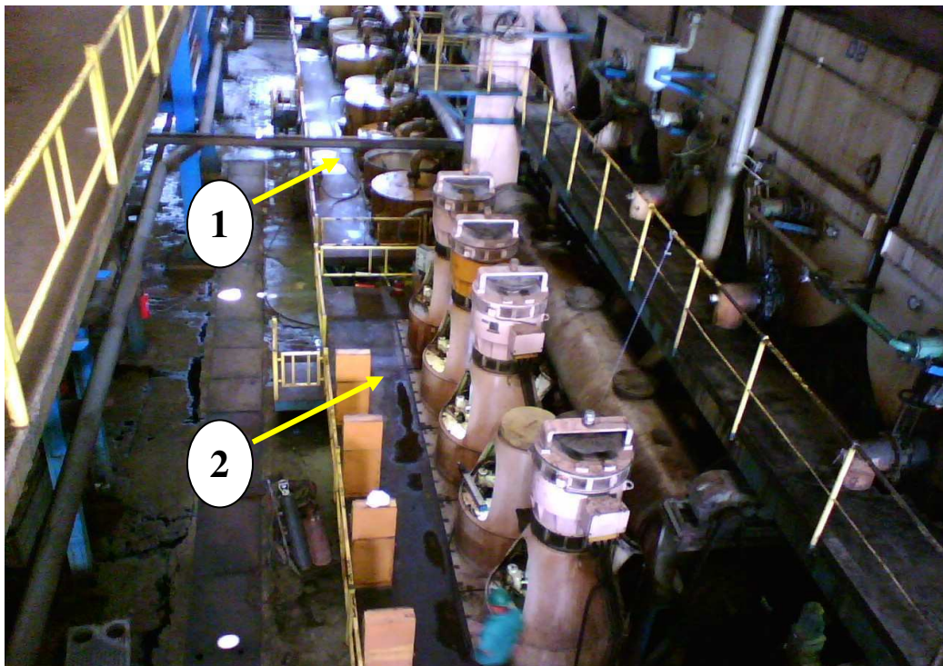
Figura 12: 1 – Centrífugas de mel, 2 – Centrífugas de secagem.
