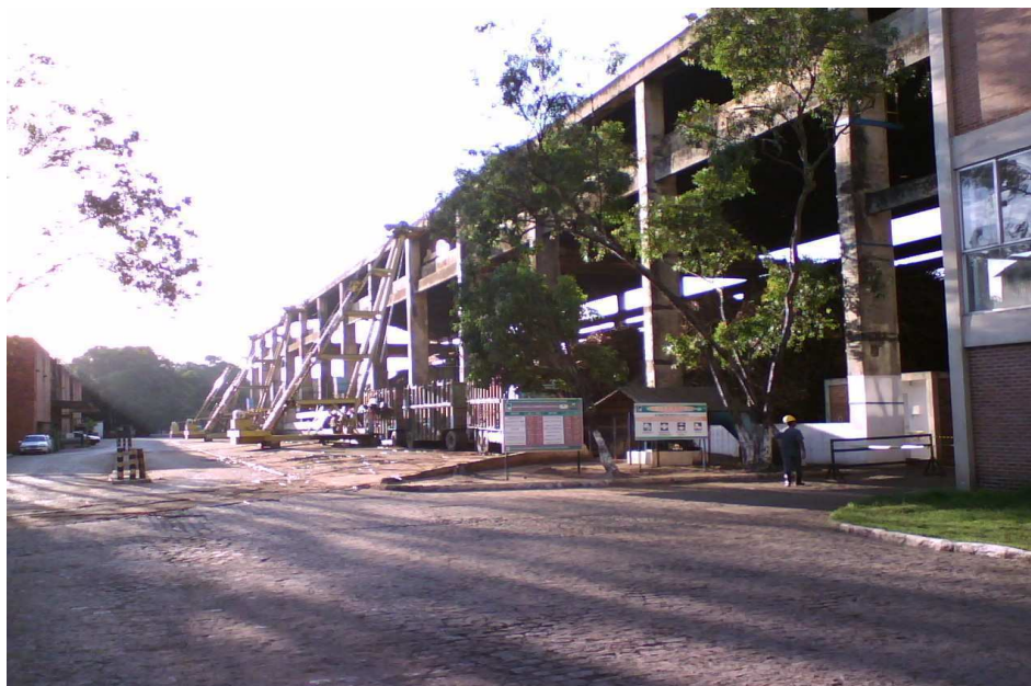
Figura 07: Recepção e preparo, caminhões sendo descarregados.
