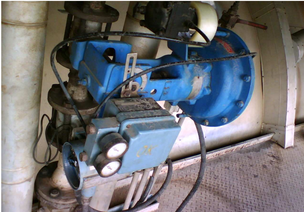
Figura 14: 1 – Válvula, 2 – Posicionador, 3 – Sensor de nível.
