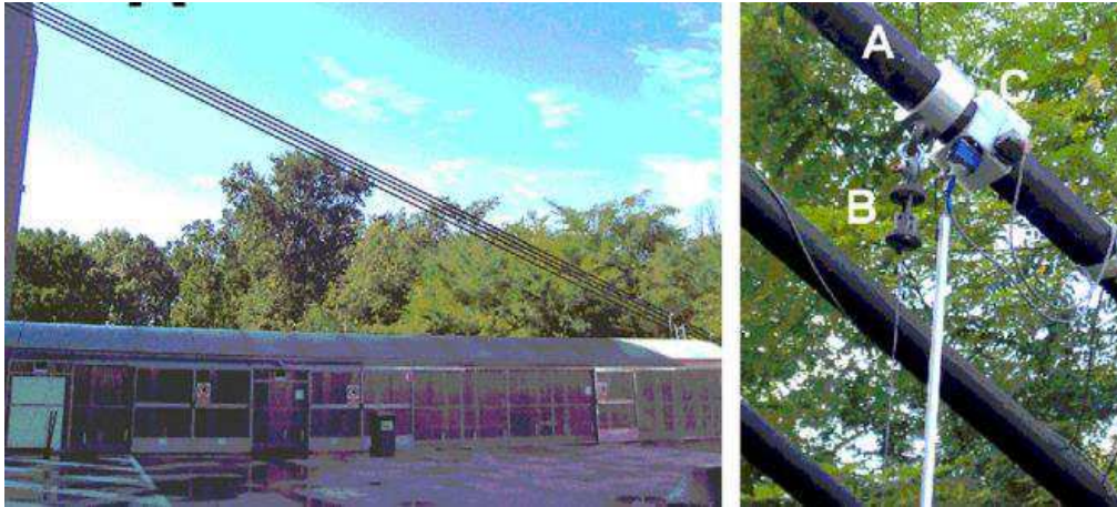
Figura 44 – Vista dos 4 cabos da ponte estaiada, onde: (A) cabo. (B) Dispositivo amortecedor de LMF. (C) Acelerômetro utilizado para realização de medições.
