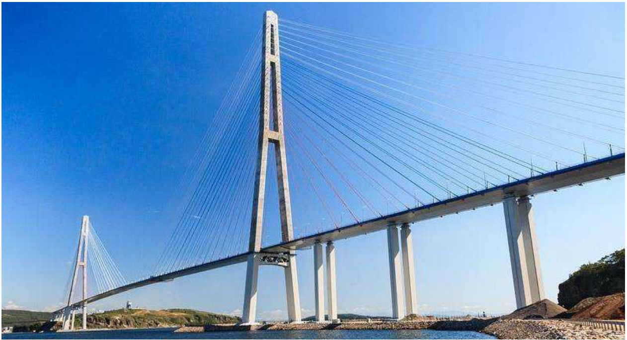
Figura 9 – Ponte da ilha Ruskky, com vão principal de 1104m.
