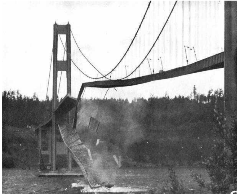
Figura 19 – Colapso da ponte de Tacoma Narrows.
