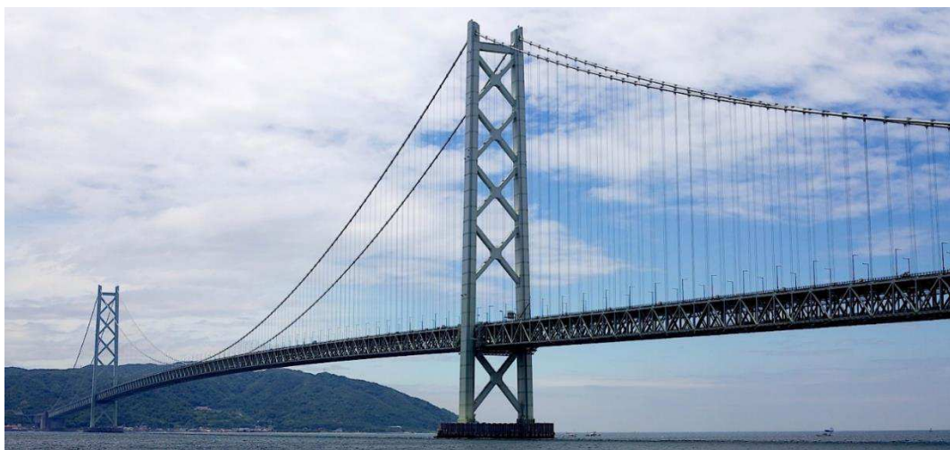
Figura 6 – Ponte suspensa Akashi Kaikyo, com vão principal de 1991m.
