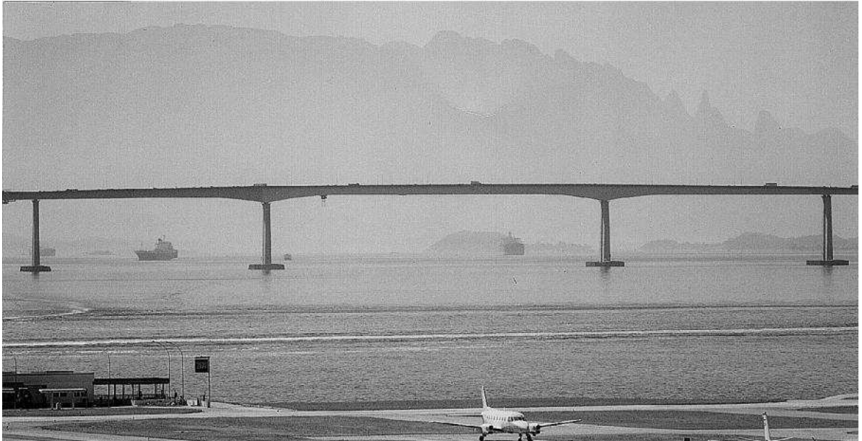
Figura 2 – Vão principal da ponte Rio-Niterói, medindo 300m, sendo esta uma das maiores pontes de vigas do mundo.
