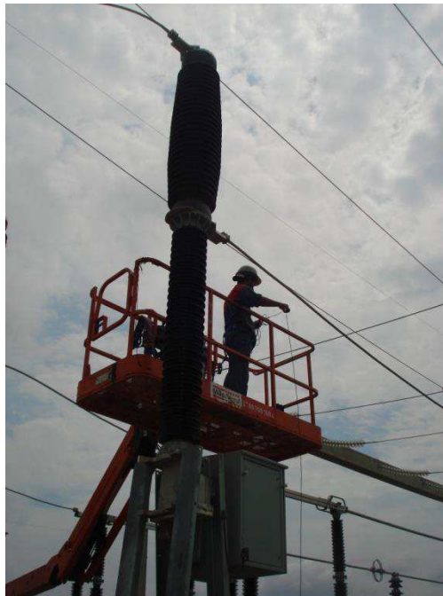
Figura 2.7 – Disjuntores a SF 6
