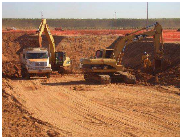
Figura 4.7 – Execução da Terraplanagem
