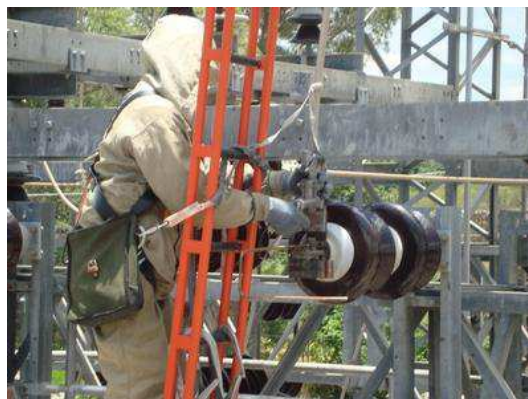
Figura 38 - Fotografia do Método ao Potencial Ativo utilizando escada isolante.
