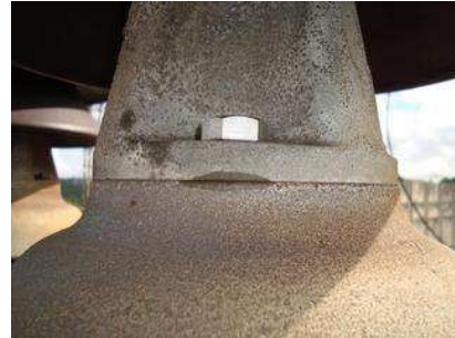
Figura 54 - Fotografia do parafuso substituído antes de aço e depois de aço inox, da base da cadeia de isolador do tipo pedestal.
