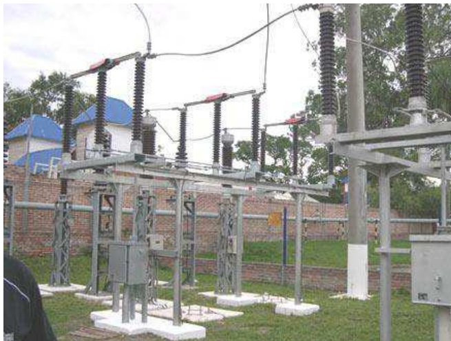
Figura 15 - Fotografia de uma Chave Seccionadora de Dupla Abertura de 132 kV.
