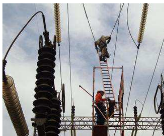
Figura 40 - Fotografia do Método ao Potencial utilizando conjunto andaime e escada para conseguir distância vertical.
