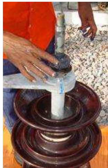
Figura 49 - Fotografia do Eixo do Mancal depois da limpeza e lubrificação.
