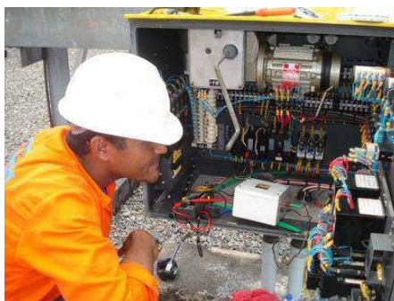
Figura 52 - Fotografia da realização da manutenção do circuito auxiliar.
