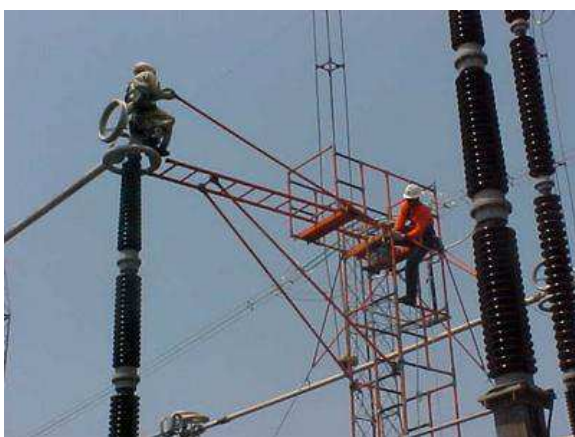
Figura 39 - Fotografia do Método ao Potencial utilizando conjunto andaime e escada para conseguir distância horizontal.
