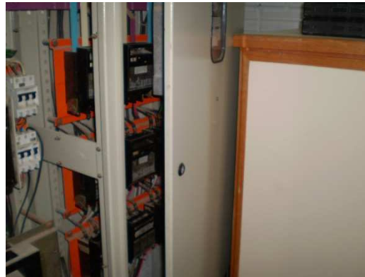
Figura 33-Quadro elétrico obstruído
