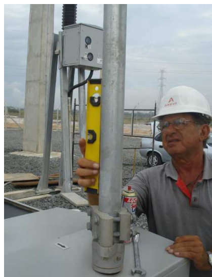
Figura 72 – Verificação do alinhamento e nivelamento das seccionadoras.
