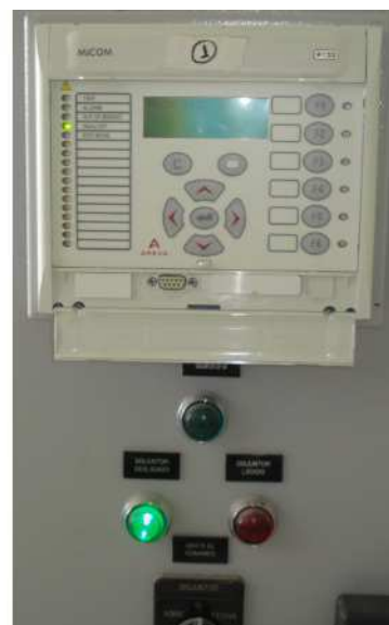
Figura 42 – Relé MiCOM P132 (AREVA) para proteção de transformadores.
