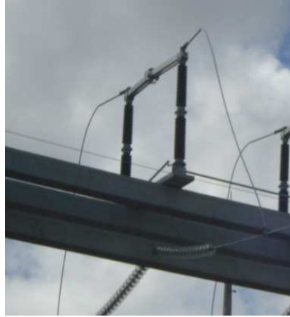
Figura 63 – Seccionadora aérea.
