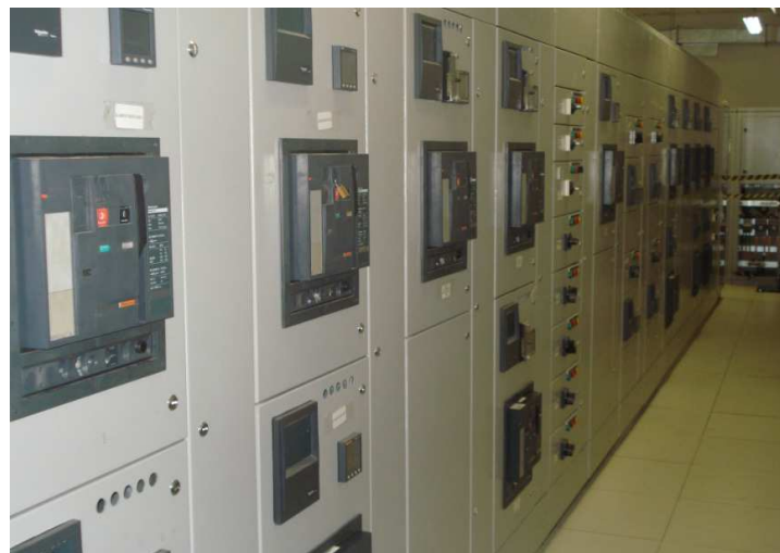
Figura 11 – Centro de Distribuição de Cargas (CDC).
