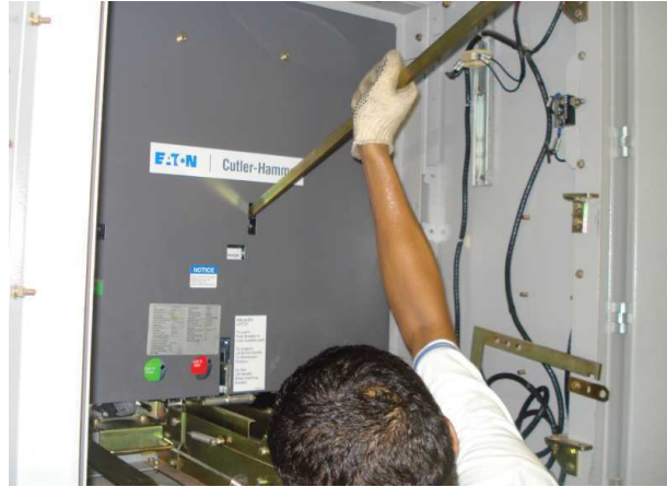
Figura 39 – Procedimento para carregamento de mola.
