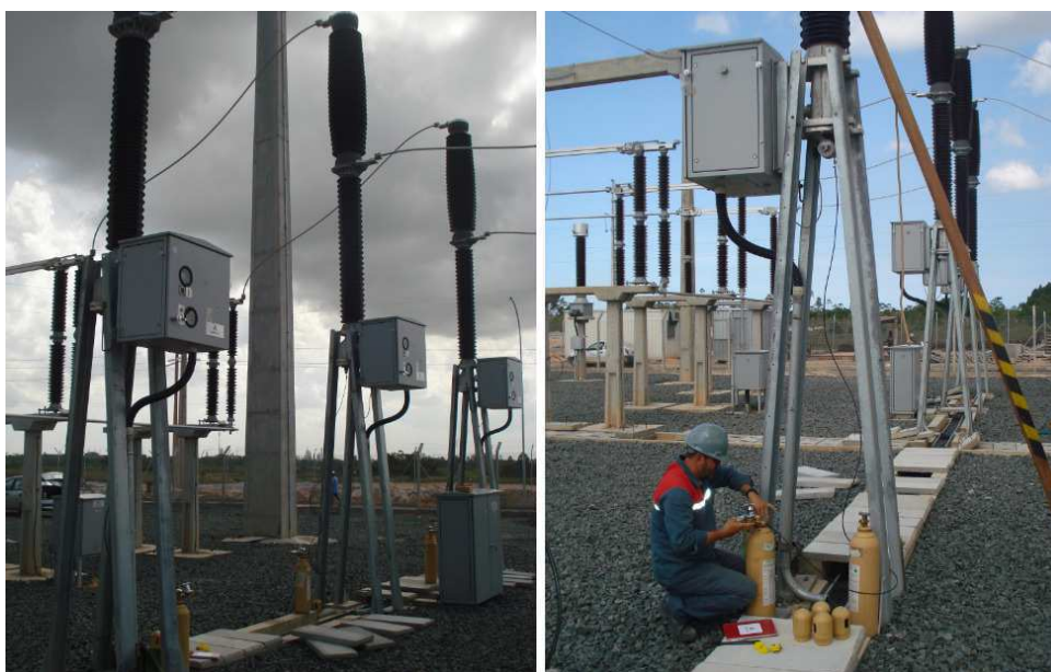
Figura 68 – Preenchimento dos disjuntores com gás SF 6 .
