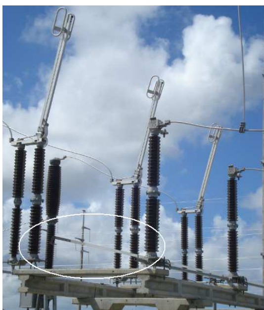
Figura 61 – Seccionadora c/ lâmina de terra Figura 62 – Seccionadora s/ lâmina de terra
