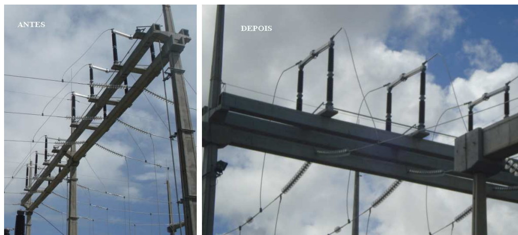
Figura 77 – Aplicação de conectores prolongados nas chaves seccionadoras aéreas.
