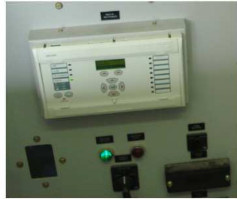
Figura 41 – Relé MiCOM P343 (AREVA) para proteção de geradores.
