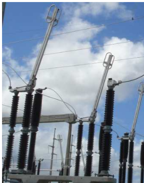
Figura 61 – Seccionadora c/ lâmina de terra Figura 62 – Seccionadora s/ lâmina de terra
