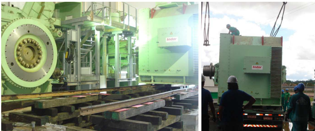
Figura 46 – Retirada dos geradores INDAR para manutenção.
