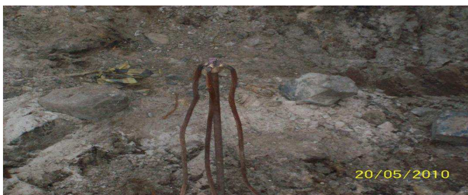
Figura 2. Solda exotérmica na haste de aterramento.
