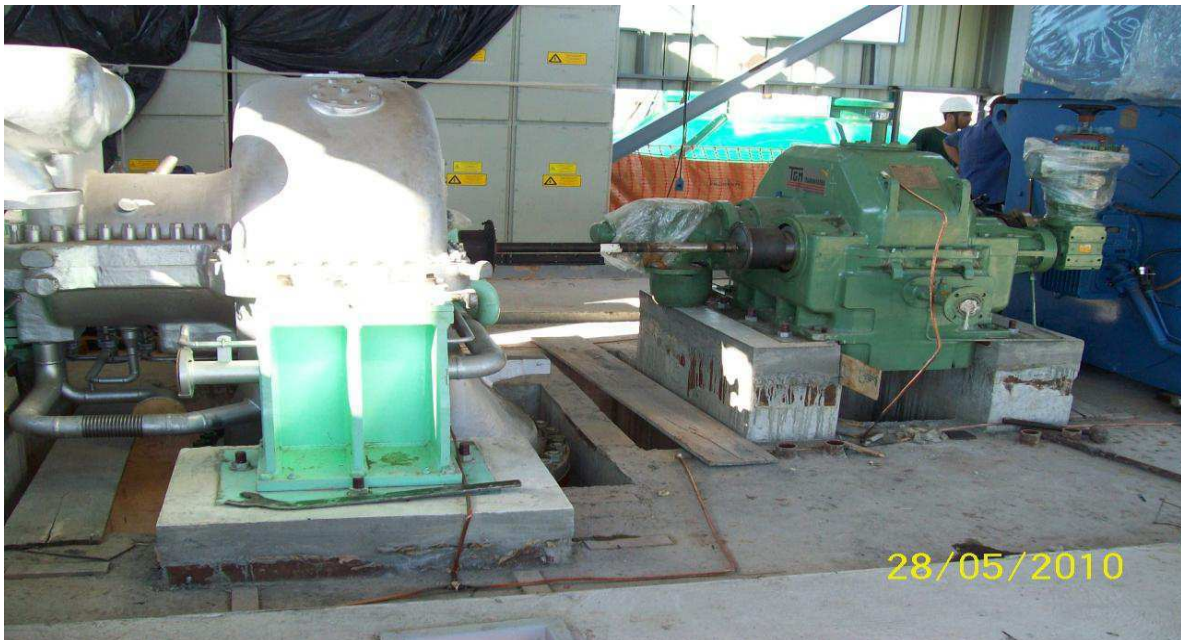
Figura 12. Turbina-Redutor-Gerador
