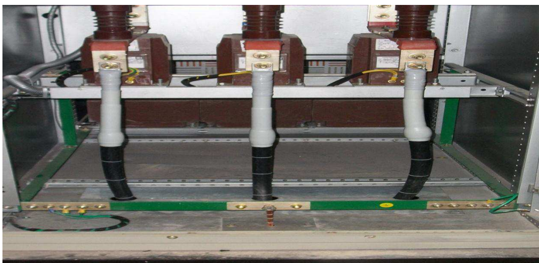
Figura 24. Muflas feitas nos cabos de média tensão no PNDMT-SE.
