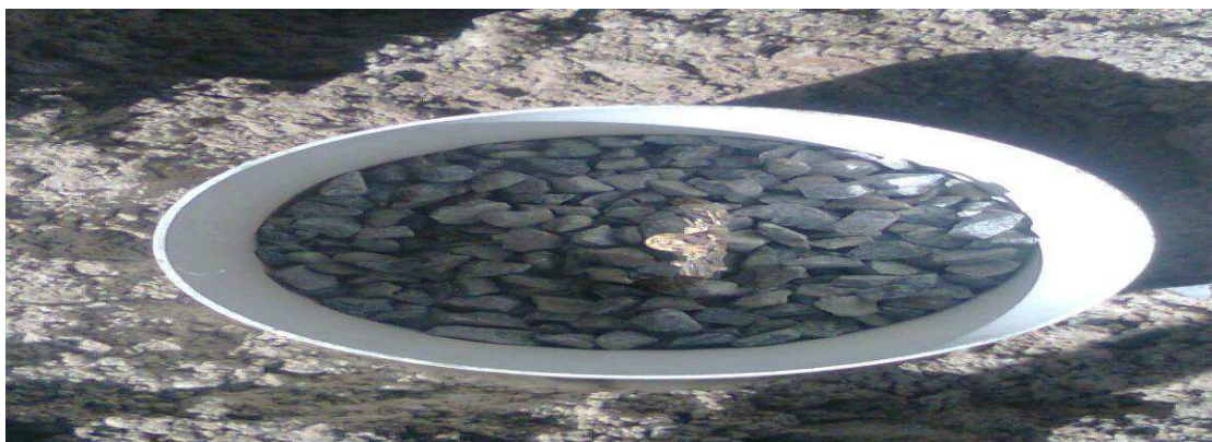
Figura 5. Caixa de inspeção.
