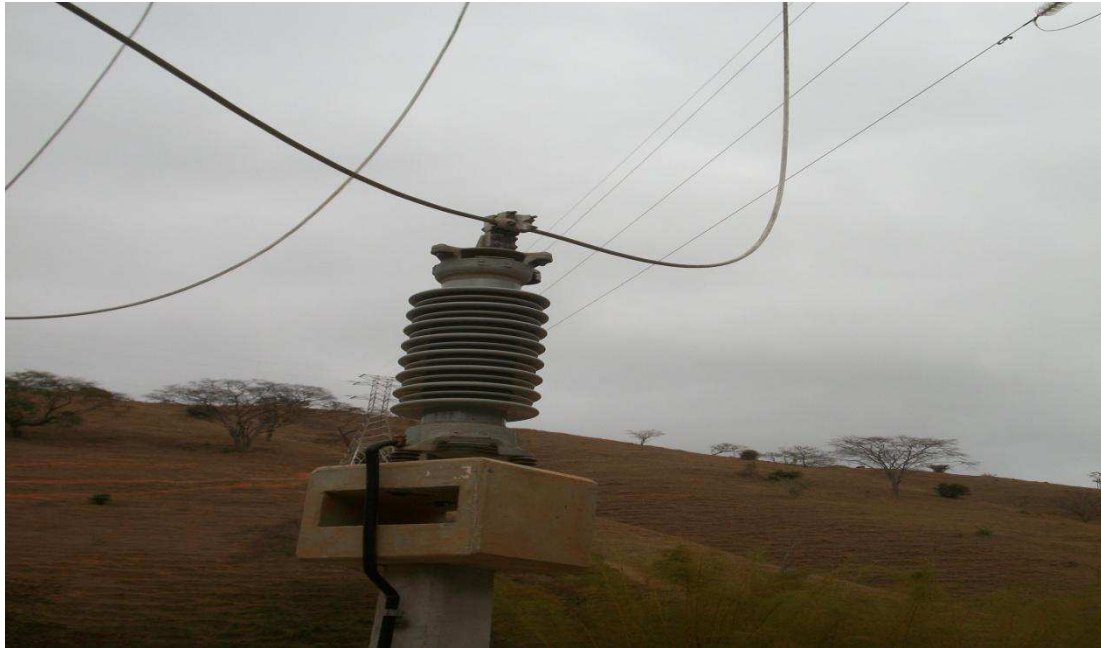
Figura 18. Pára-Raio utilizado na SE SJP.
