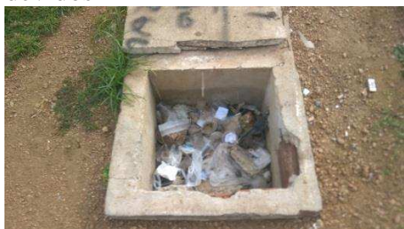
Figura 15 - Materiais sem acondicionamento devidos
