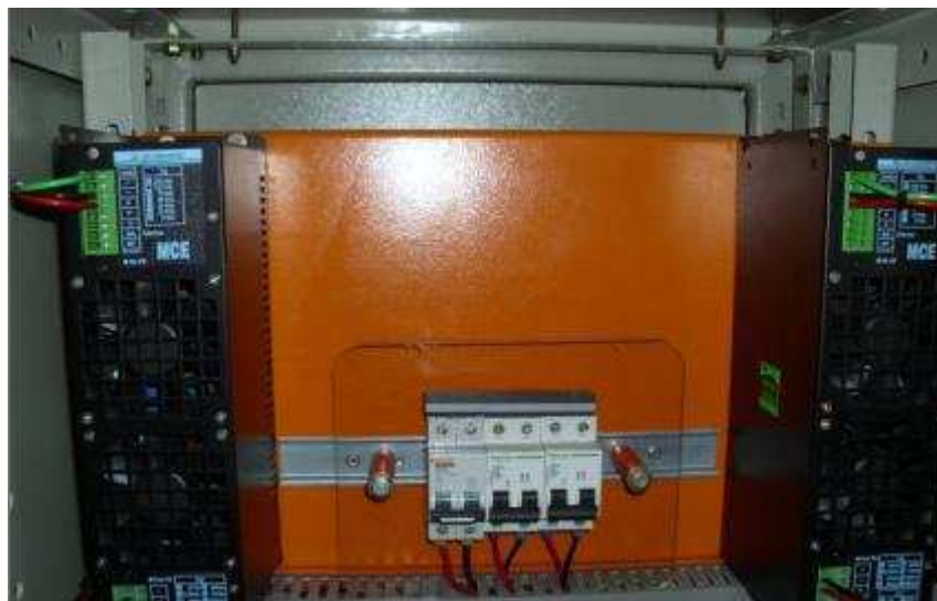
Figura 22 - Quadro para conversão da tensão 125 Vcc - 24 Vcc.
