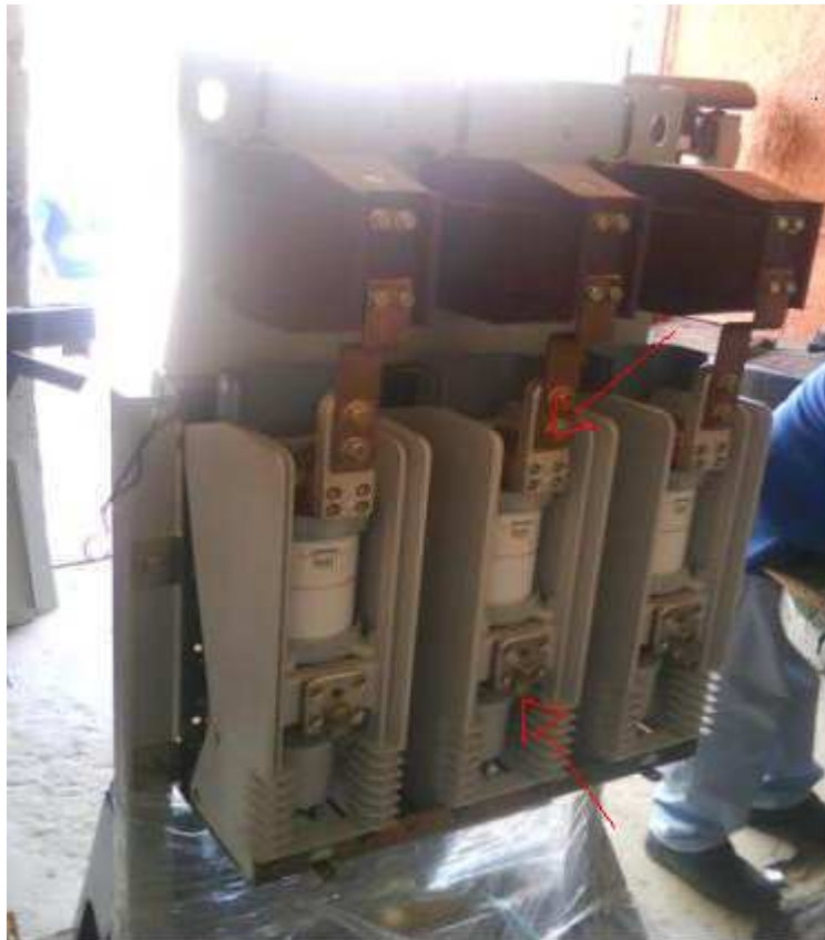
Figura 8 - Teste de Resistência de Isolamento de um Disjuntor.
