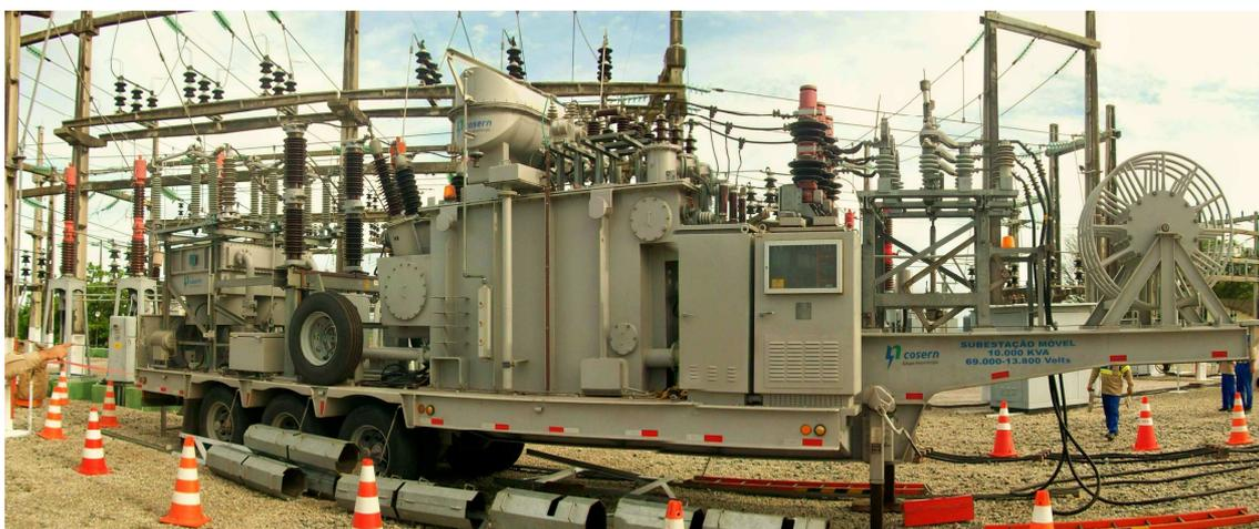
**Figura 4: Subestação Móvel da COSERN**
