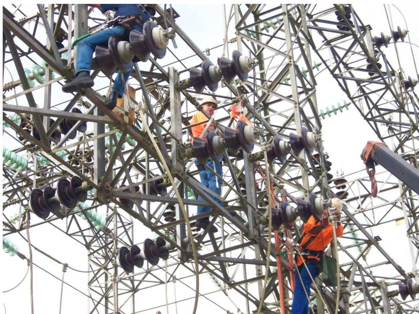
**Figura 5: Substituição de chaves seccionadoras**
