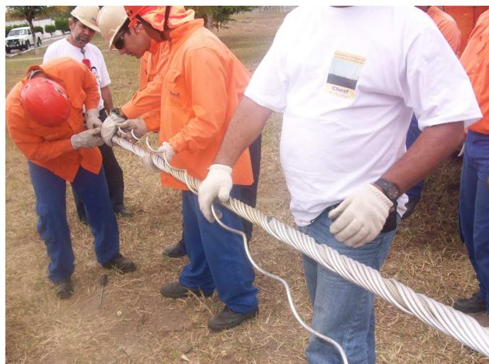
**Figura 13: Colocação dos pré-formados**
