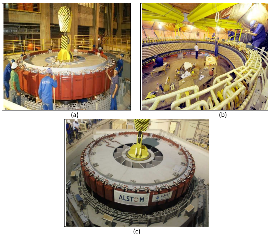
Figura 2. (a) Rotor (b) enrolamentos do estator e (c) acoplamento da máquina 1 da UHE São José.
