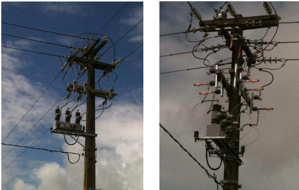
Figura 31: Religador (NA) instalado pela empreiteira.
