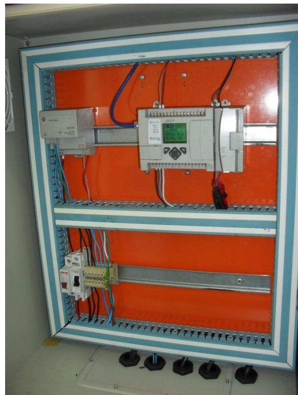
Figura 33 – Foto do PLC da usina de beneficiamento.
