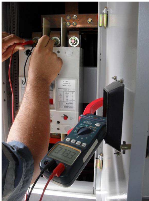
Figura 6 – Foto da medição de tensão de linha. Figura 7 – Foto da medição de corrente de linha.
