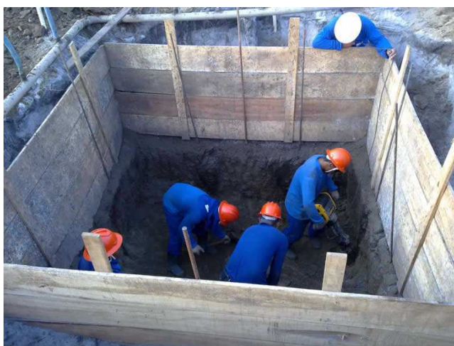
Figura 2.15: Realização das escavações da estrutura 9/1 com apoio de bomba d'água, escoramento, rebaixador de nível de lençol freático e rompedor elétrico.
