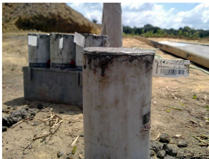
Figura 2.18: Detalhe dos corpos cilíndricos feitos durante a aplicação do concreto na fundação da estrutura 13/4.
