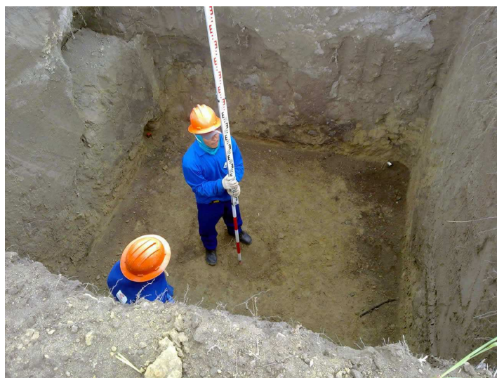
Figura 2.16: Nivelamento de fundo de cavas da estrutura 10/2.
