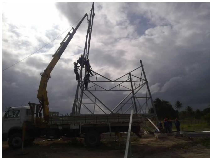
Figura 2.20: Serviços de premontagem e montagem da estrutura 13/3.
