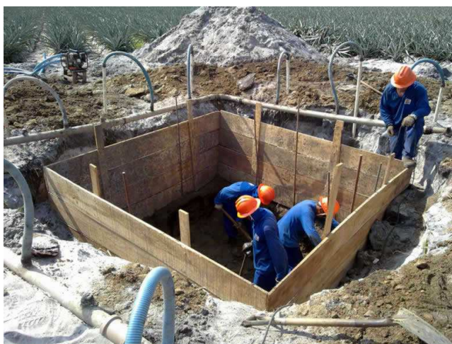
Figura 2.14: Realização das escavações da estrutura 9/1 com apoio de bomba d'água, escoramento e rebaixador de nível de lençol freático.
