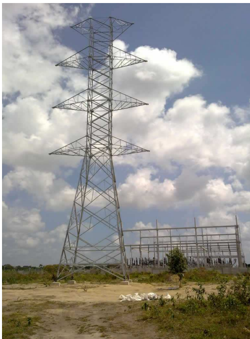
Figura 2.22: Estrutura 13/4 com montagem concluída. SE Santa Rita II em construção ao fundo.
