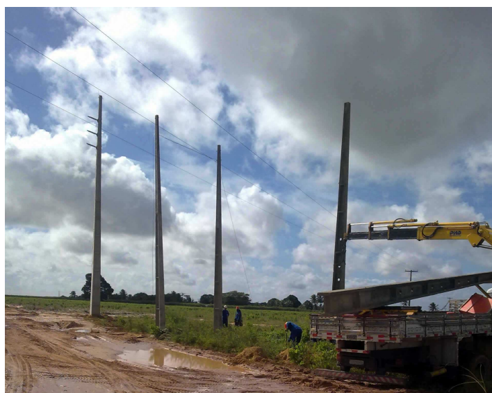
Figura 2.23: Travessia sobre linha 13,8 kV na obra da LT Mataraca - Jacaraú.
