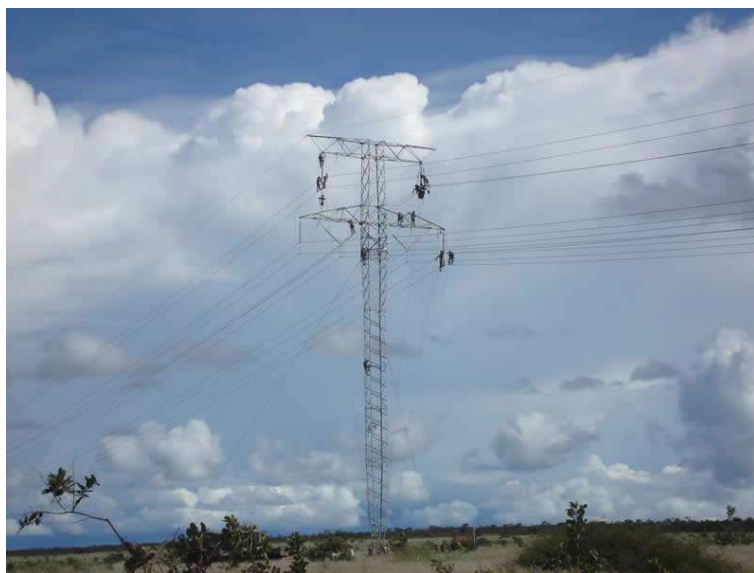
Figura 1.6: Realização de manutenção em torre de 230 kV estaiada da LT Jauru - Vilhena (INCOMISA, 2011).
