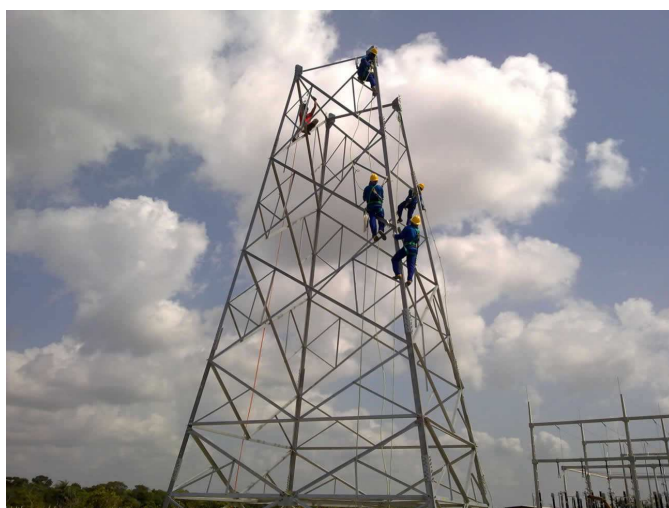
Figura 2.21: Realização de treinamento para trabalho e resgate em altura na estrutura 13/4.
