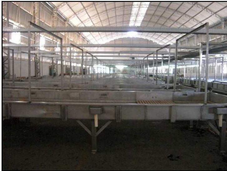
Figura 27- Instalação e montagem dos bancos de carga.
