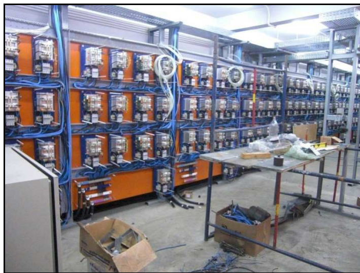
Figura 28- Instalação e montagem dos módulos SPM.
