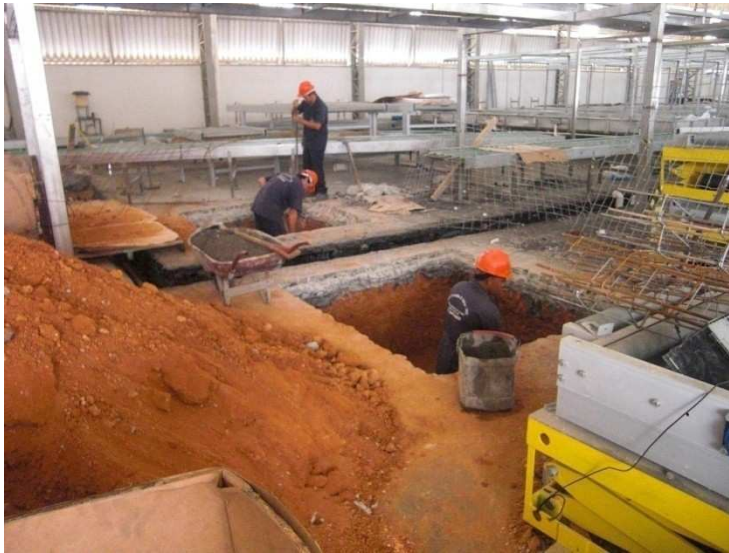
Figura 23- Instalação e montagem do Sistema Transportador de Baterias.
