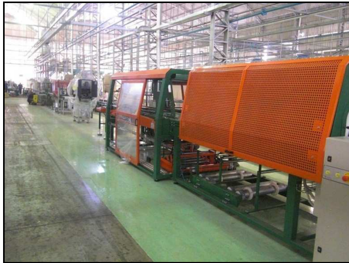
Figura 32- Instalação das máquinas na linha 04 do acabamento.
