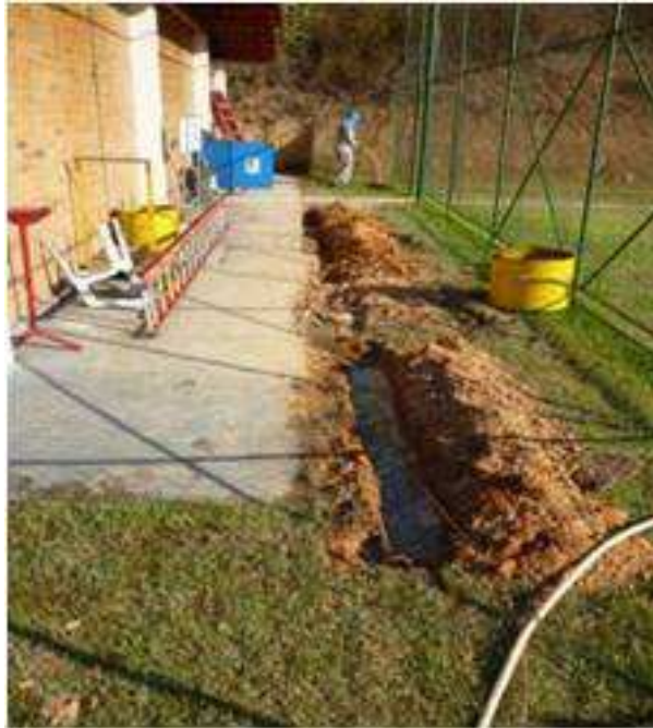
Figura 15: Execução das obras de SPDA no Grêmio
