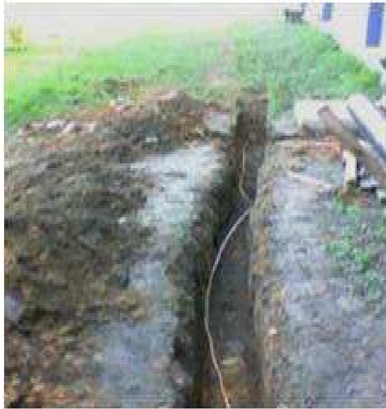
Figura 13: Execução das obras de SPDA da central de resíduos
