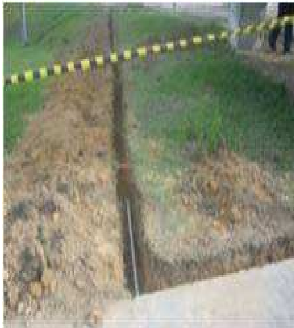
Figura 16: Execução das obras de SPDA na passarela de acesso
